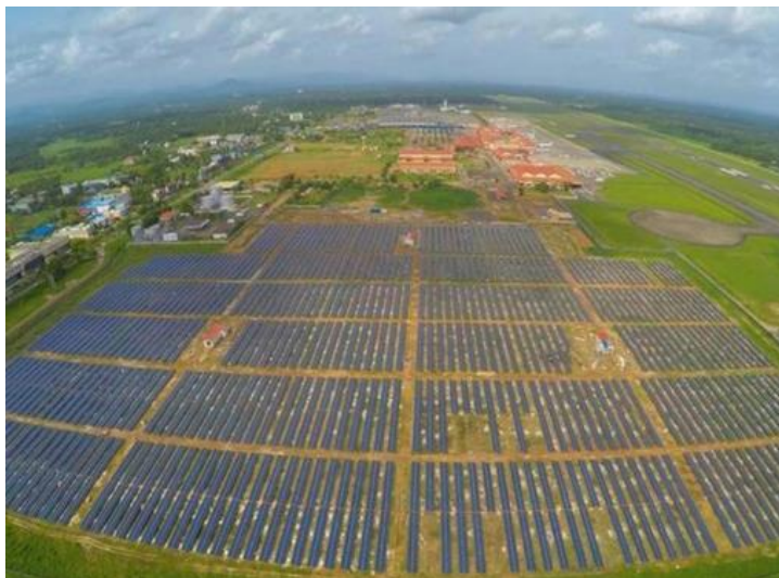
Figura 66 - Impianto fotovoltaico realizzato presso l'aeroporto di "Kochi" a Cochin, India
