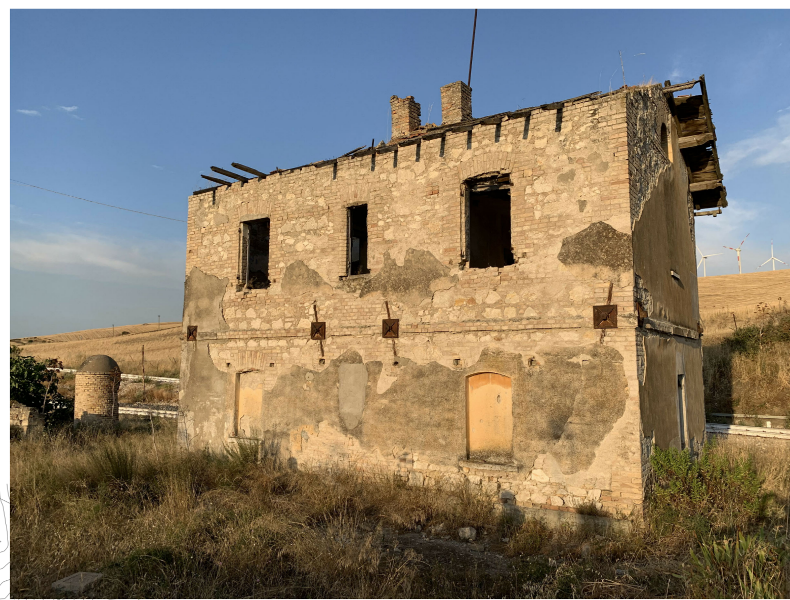
Fabbricato FS esistente da adeguare per alloggiamento CABINA TE
