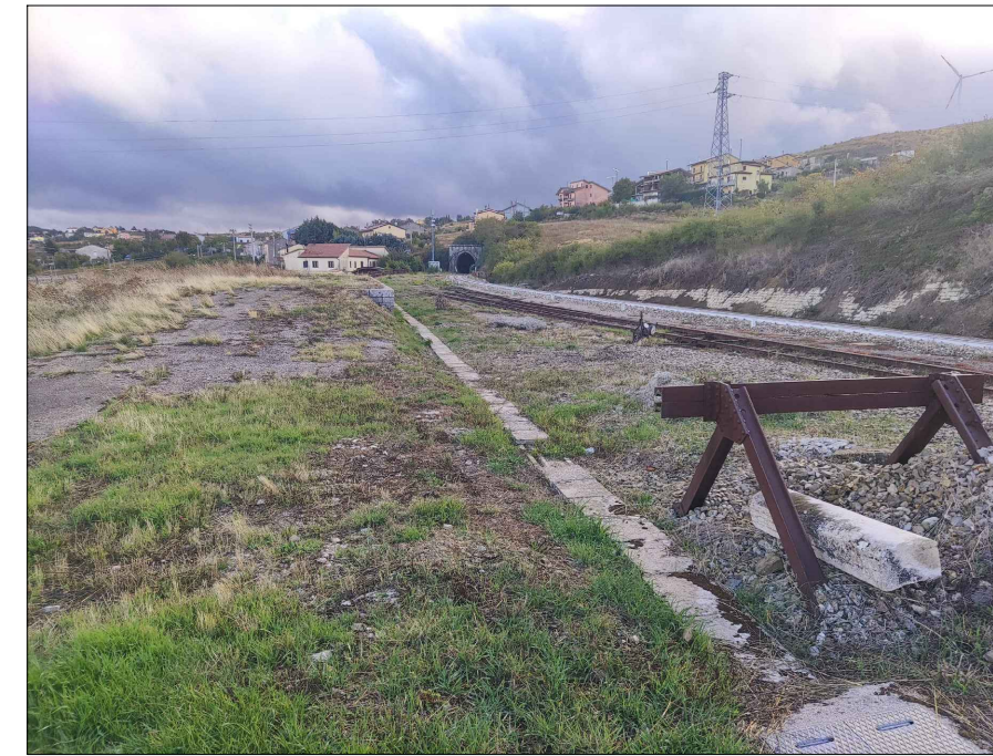
AREA TECNICA AT1-37 - FOTO 1
