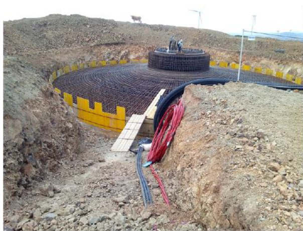
Posa ferri e casseratura
