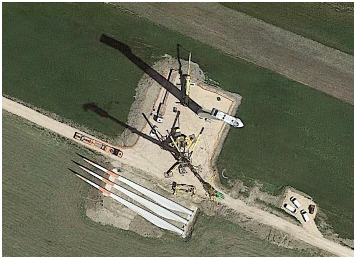
Figura 2.6 – Esempio di piazzola in fase di costruzione
