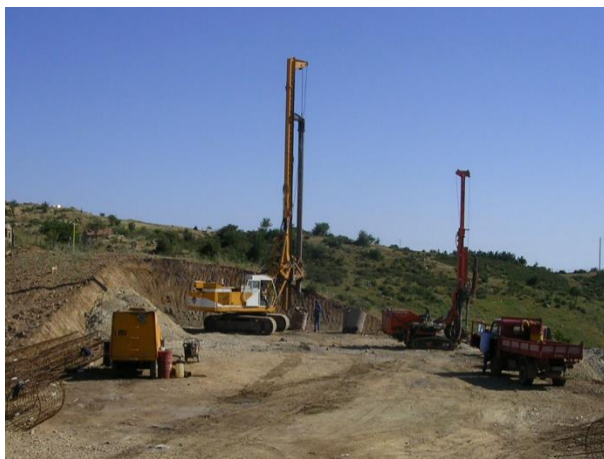
Realizzazione pali trivellati
