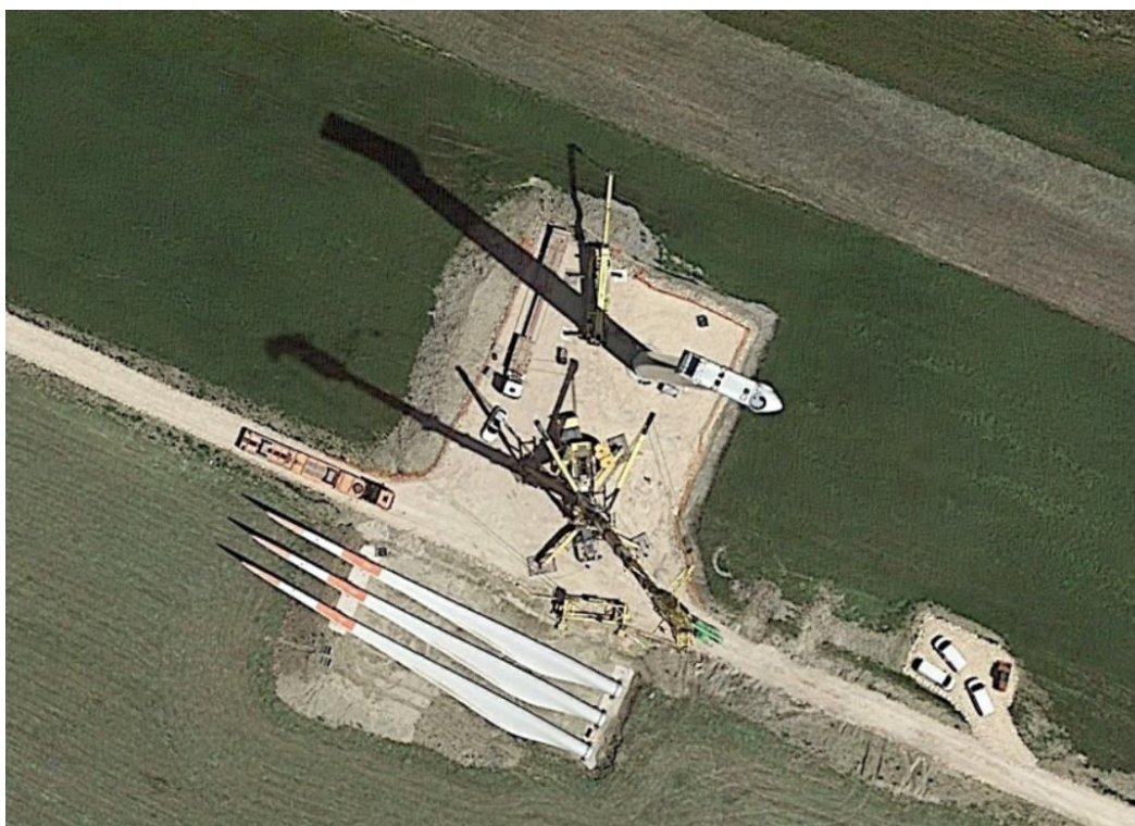
Figura 4.8: Esempio di piazzola in fase di costruzione
