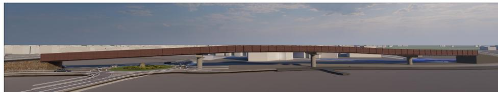
STUDIO CROMATICO - Ipotesi 3 - Impalcato con finitura cromatica RAL 7047 (con costolature concii in RAL 8012), Pile e pulvini in calcestruzzo armato pigmentato in pasta RAL 8012. Rivestimento muro sinistra in bozze di pietra e a destra in cemento grezzo
