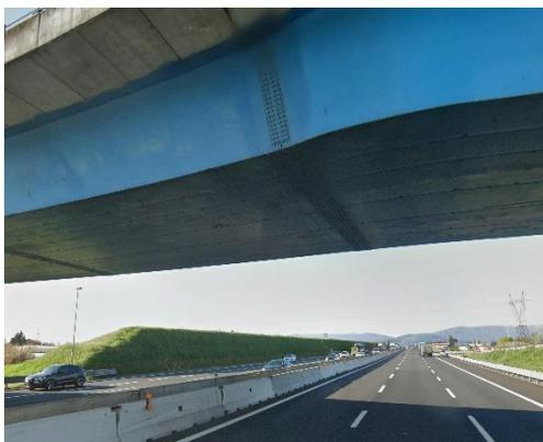
Figura 9 esempio di carenatura piana dell'intradosso di viadotto stradale
