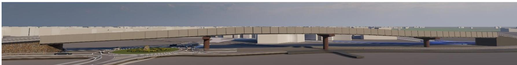
**IPOTESI 2 – Impalcato con finitura cromatica RAL 7047, Pile e pulvini in calcestruzzo armato pigmentato in pasta RAL 8012. Rivestimento muro sinistra in bozze di pietra e a destra in cemento grezzo**
