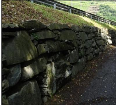
muratura di sostegno rilevato stradale in massi
