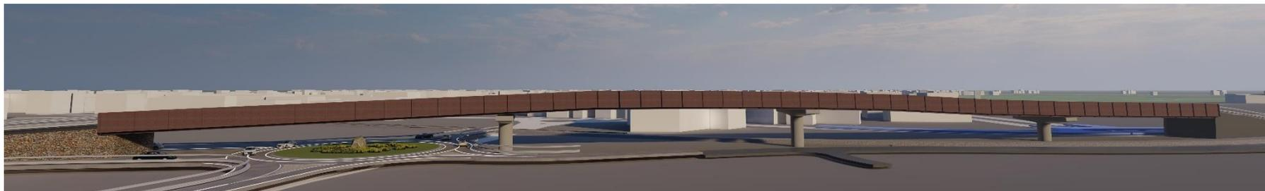
**IPOTESI 1 – Impalcato con finitura cromatica RAL 8012, Pile e pulvini in calcestruzzo armato pigmentato in pasta RAL 7047. Rivestimento muro sinistra in bozze di pietra e a destra in cemento grezzo**
