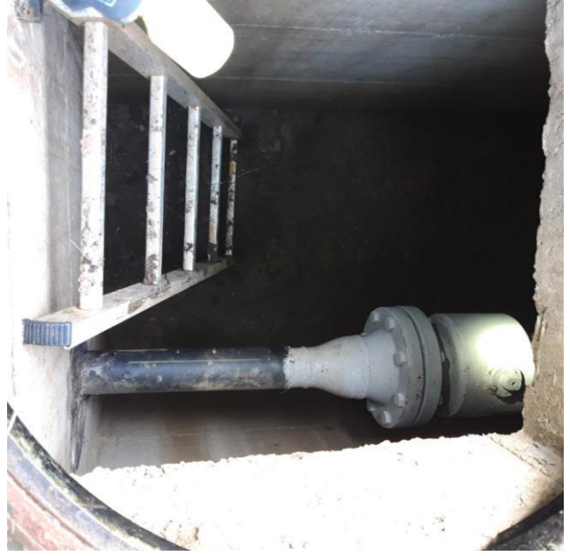
Foto 1a e 1b – Pozzetto valvola di intercettazione flusso gas dalla rete di trasporto alla rete di distribuzione
