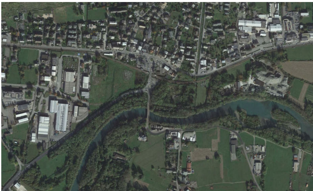
Figura 1: Tratto di SS38 oggetto di intervento. Al centro il passaggio a livello
