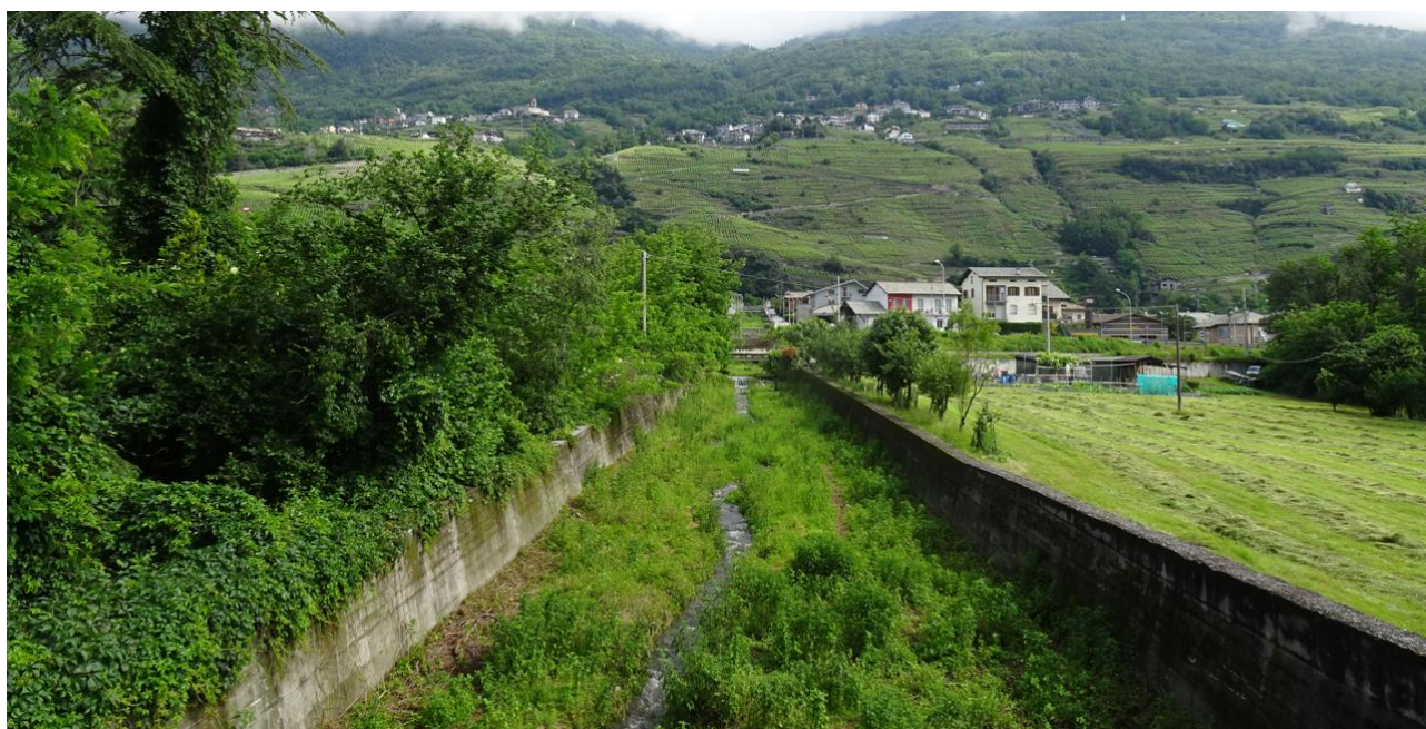
Figura 2: corridoio fluviale del Torrente Davaglio percorribile anche dalla fauna selvatica
