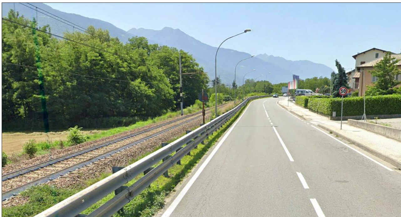
Figura 60 – Vista lungo la SS 38 nel tratto in affiancamento alla linea ferroviaria. Sulla sinistra si nota il popolamento arboreo di origine antropomorfa e sulla sinistra la fascia periurbana di Montagna in Valtellina
