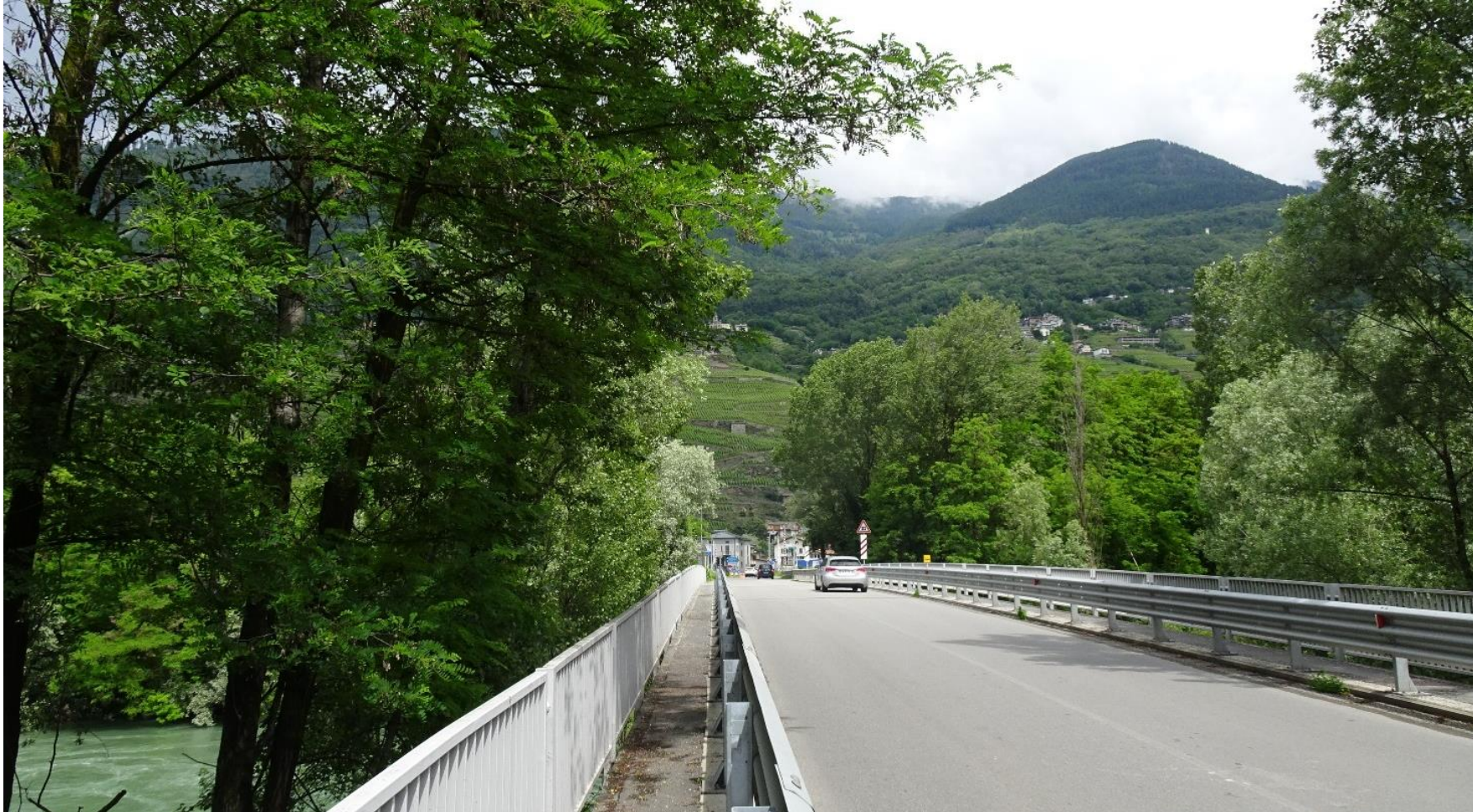
Figura 19. Visuale in piano verso nord dalla SP19 della linea ferroviaria in sponda idrografica sinistra del fiume Adda (comune di Montagna in Valtellina)
