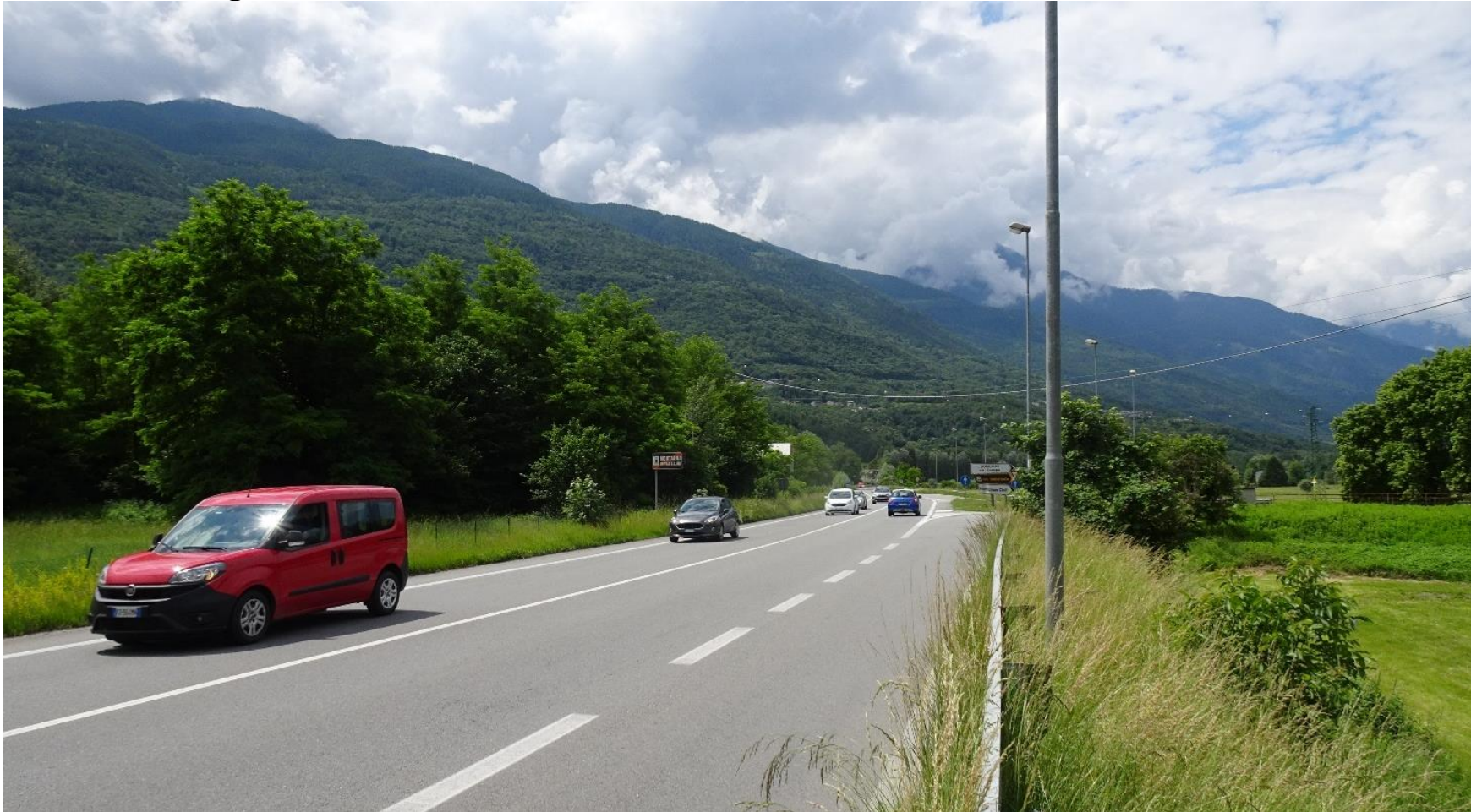
Figura 21. Visuale in piano (sud-ovest) dalla SS dello Stelvio (comune di Montagna in Valtellina)
