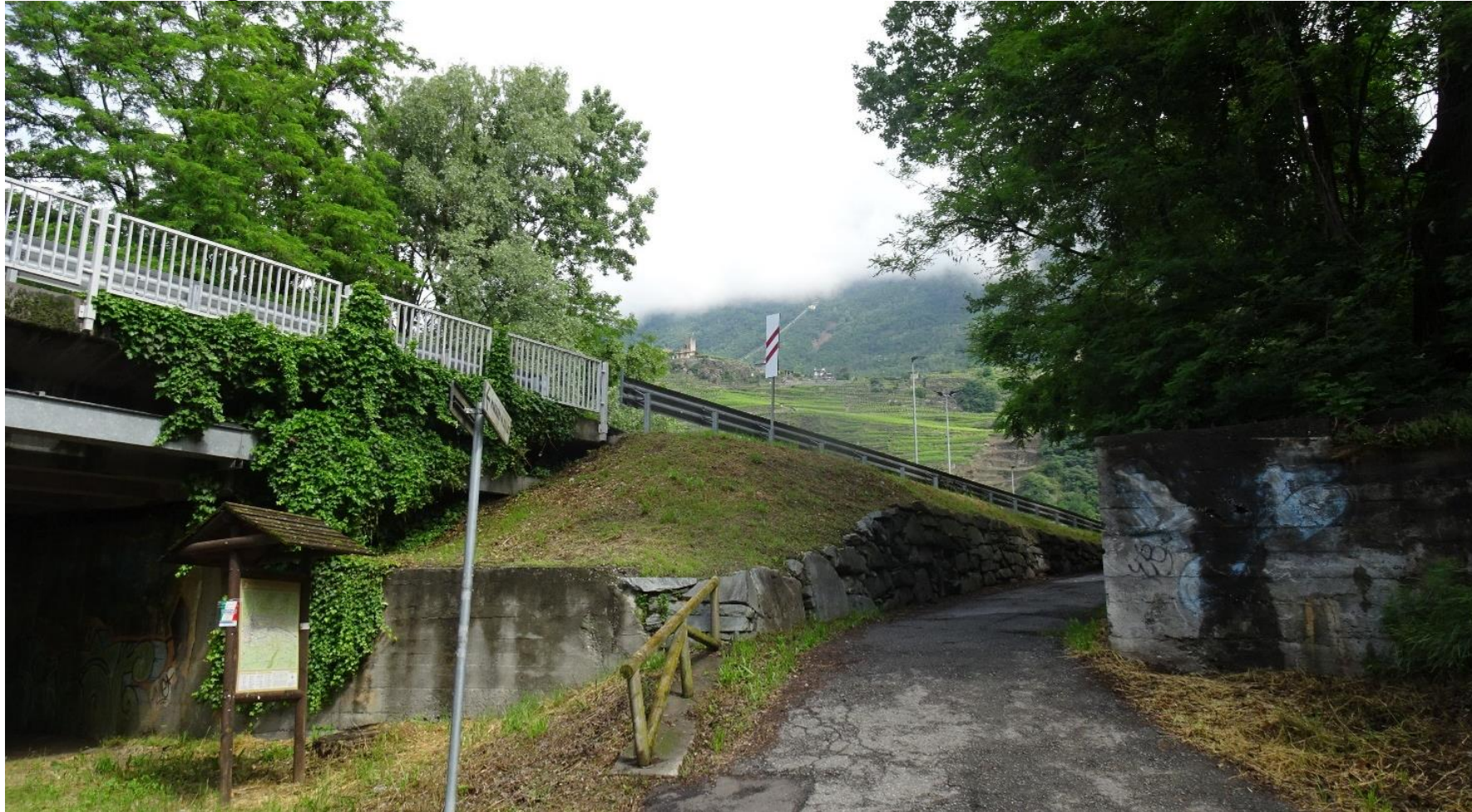
Figura 18. Visuale dal basso verso nord dal sentiero sotto la SP19 del Castello di Grumello (comune di Montagna in Valtellina)
