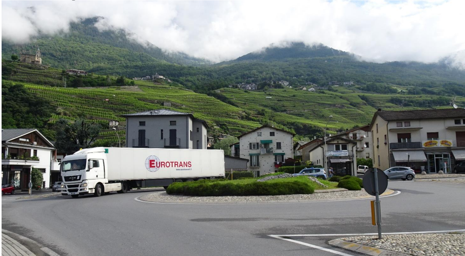
Figura 15. Visuale in piano verso nord della rotonda Strada statale 38 (comune di Montagna in Valtellina)
