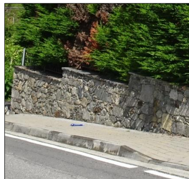
rivestimento muro con bozze di pietra
