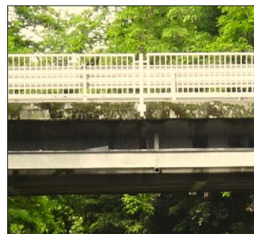
new jersey e parapetto su cavalcavia di viabilità comunale
