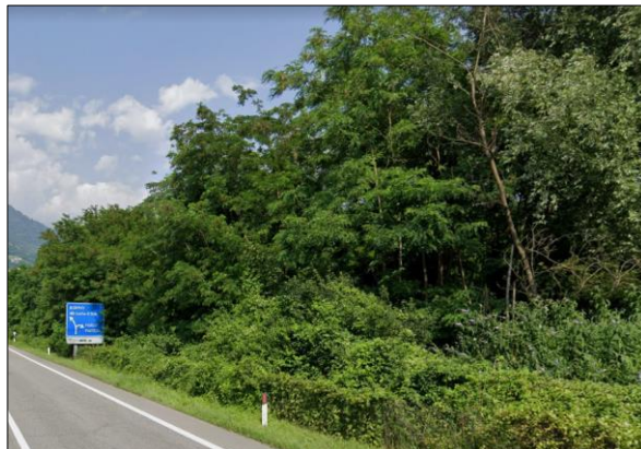
Vegetazione arboreo arbustiva antropogena al margine stradale
