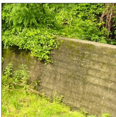
muro arginale in C.A. allo stato grezzo
