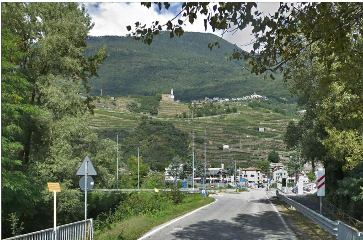
Figura 7-2 - nuova rotatoria sulla SS38 e viadotto visti dalla SP19 in corrispondenza del ponte sul F. Adda
