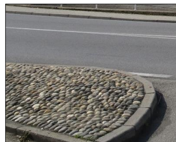
pavimentazione in acciottolato intasato in cls
