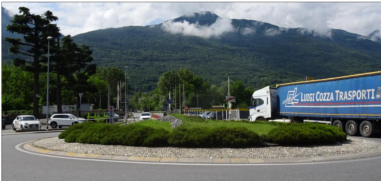
Sistemazione rotonda in contesto periurbano (SS38)
