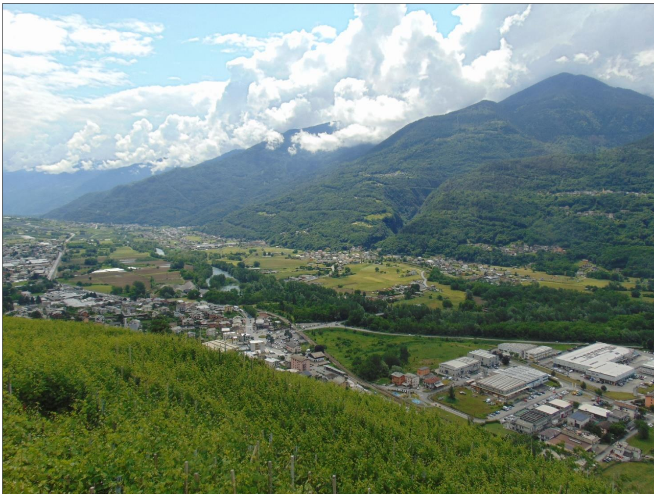
Figura 7-5 vista del nuovo viadotto da Castel Grumello lungo il percorso panoramico
