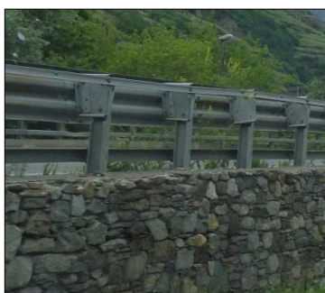
rivestimento muro di sostegno rilevato stradale
