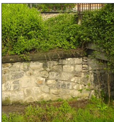
rivestimento muro arginale a valle di ponte ferroviario
