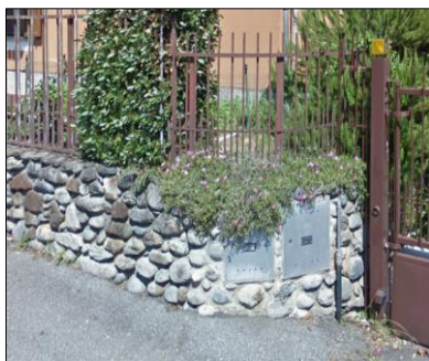
rivestimento muro con bozze di pietra di fiume accostata con le finiture in cor-ten della recinzione e del cancello
