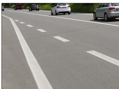
pavimentazione in asfalto
