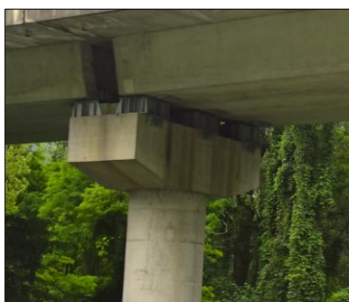
pilone ed impalcato viadotto ferroviario
