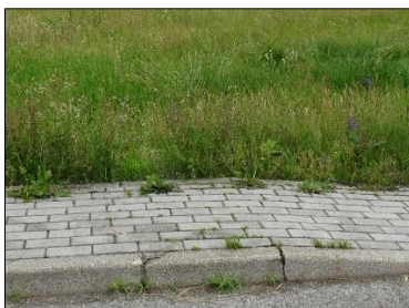
pavimentazione in betonelle cls
