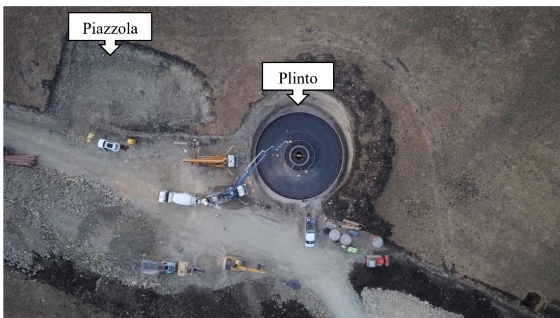
Figura 13 – Posizionamento plinto di fondazione
