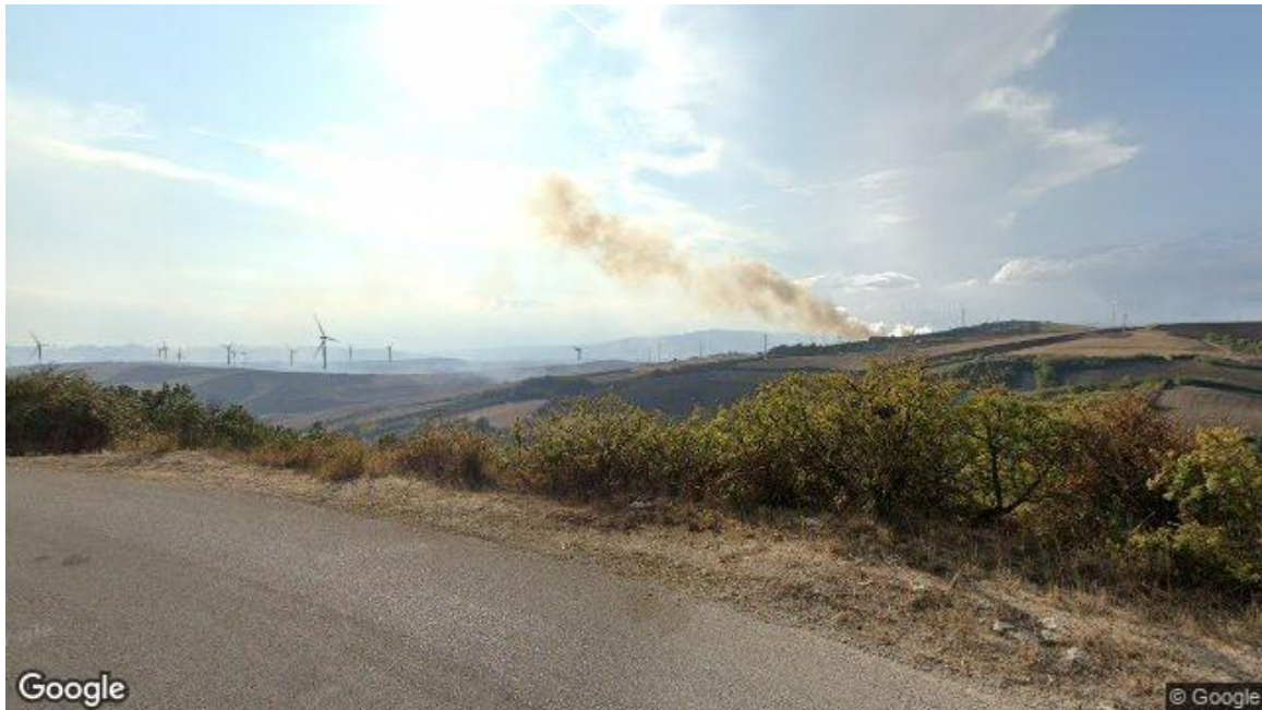
Figura 35 - ETG-1 e WTG-2 vista da SP-58
