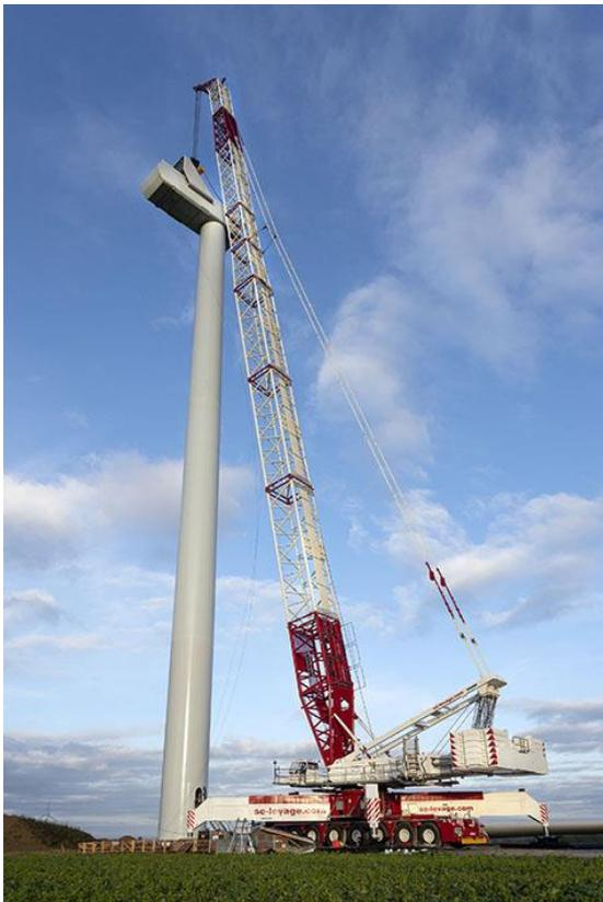
Figura 2 – Una gru tipo Liebherr 1750 durante l'installazione di un generatore eolico
