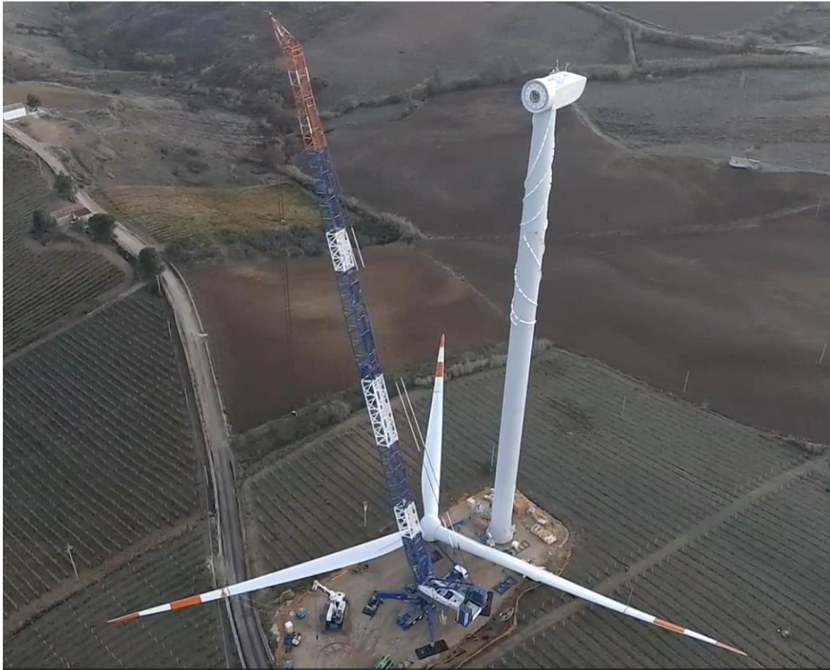
Figura 3.54: Navicella in opera sul sostegno troncoconico in acciaio e rotore assemblato a terra
