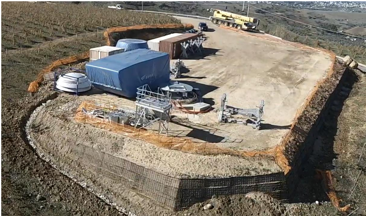
Figura 3.50: Rinfianco e rinterro del plinto completato e piazzola pronta per il montaggio
