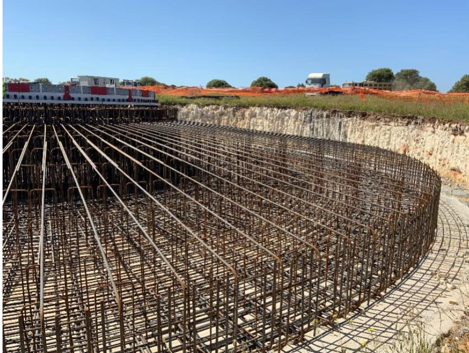
Figura 3.43: Esempio Armatura del Plinto di Fondazione
