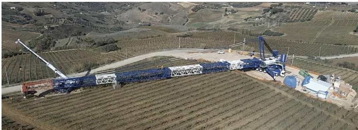
Figura 3.51: Assemblaggio completato del braccio tralicciato della gru principale
