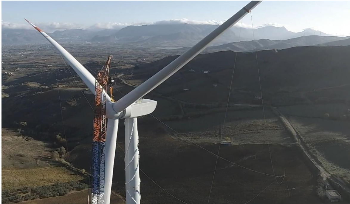
Figura 3.55: Collocazione in opera del rotore
