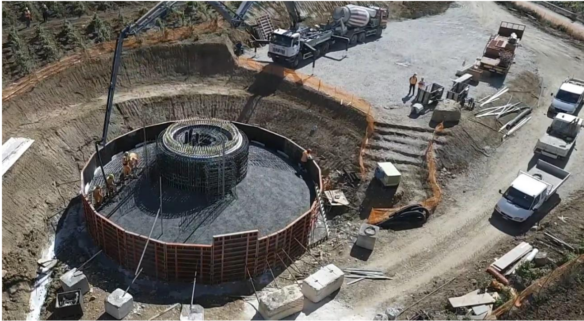
Figura 3.49: Getto del conglomerato cementizio del plinto di fondazione
