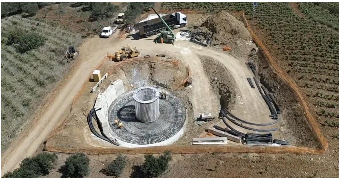
Figura 3.48: posa in opera armatura del plinto e anchor cage
