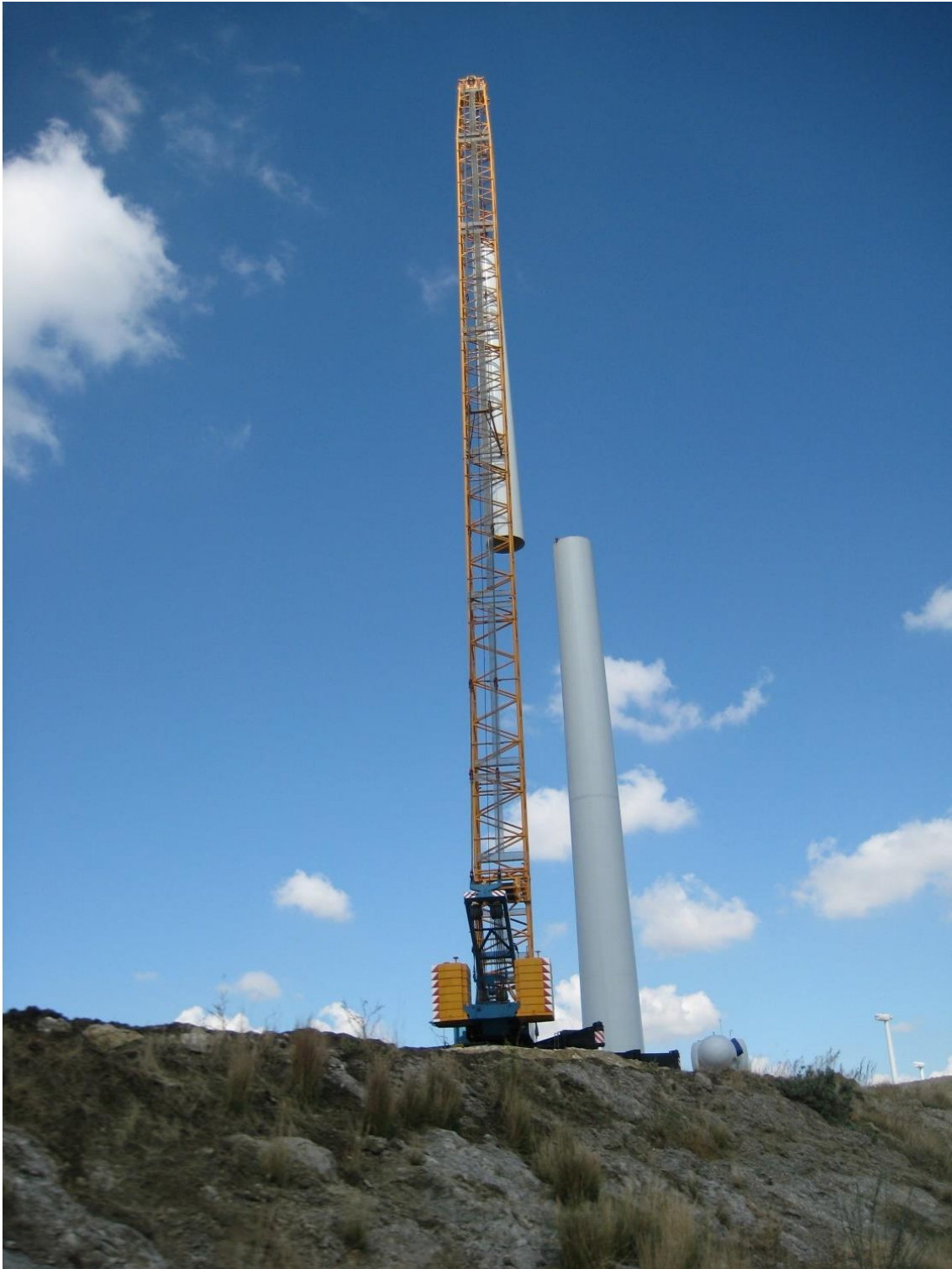
Figura 3.72: Attività di Smontaggio degli Elementi Tronco-Conici del Sostegno dell'Aerogeneratore
