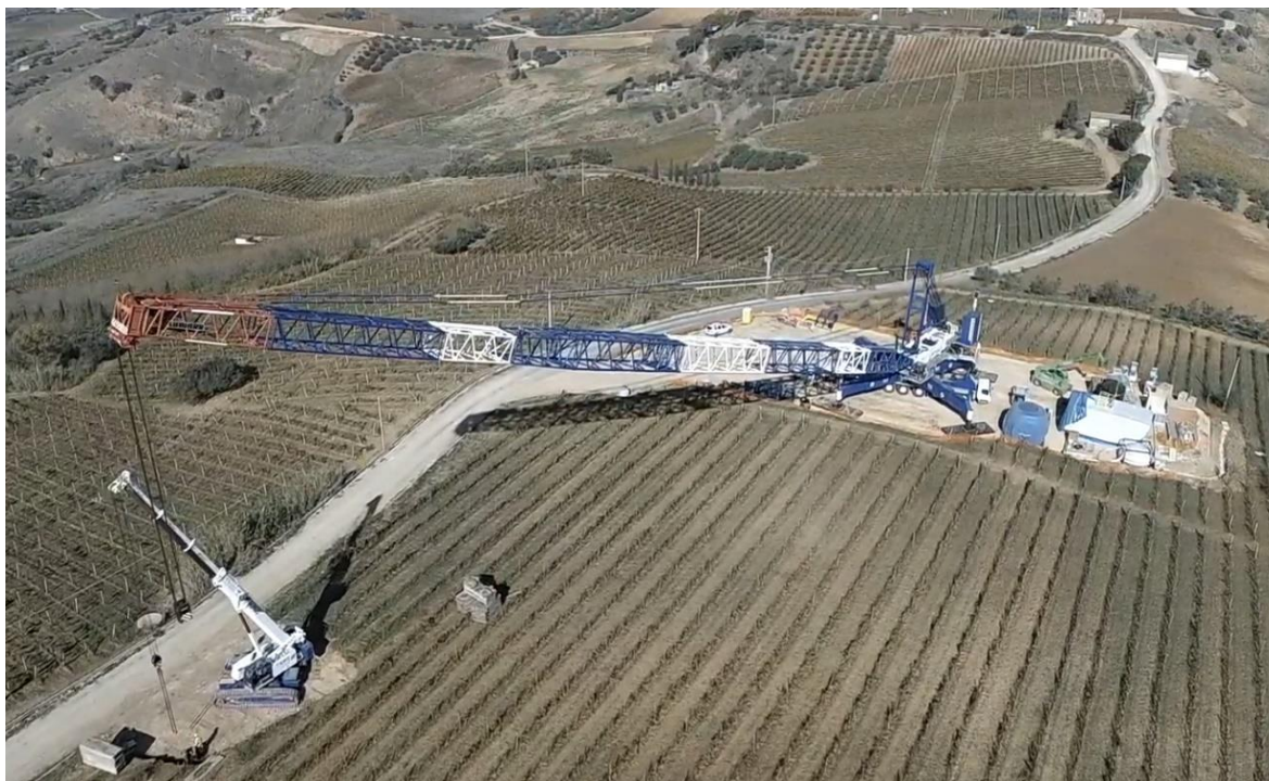
Figura 3.52: Sollevamento del braccio tralicciato
