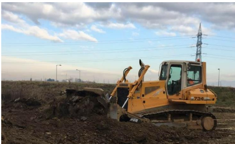
Figura 3.3: Esempio Attività di Scavo Materiale
