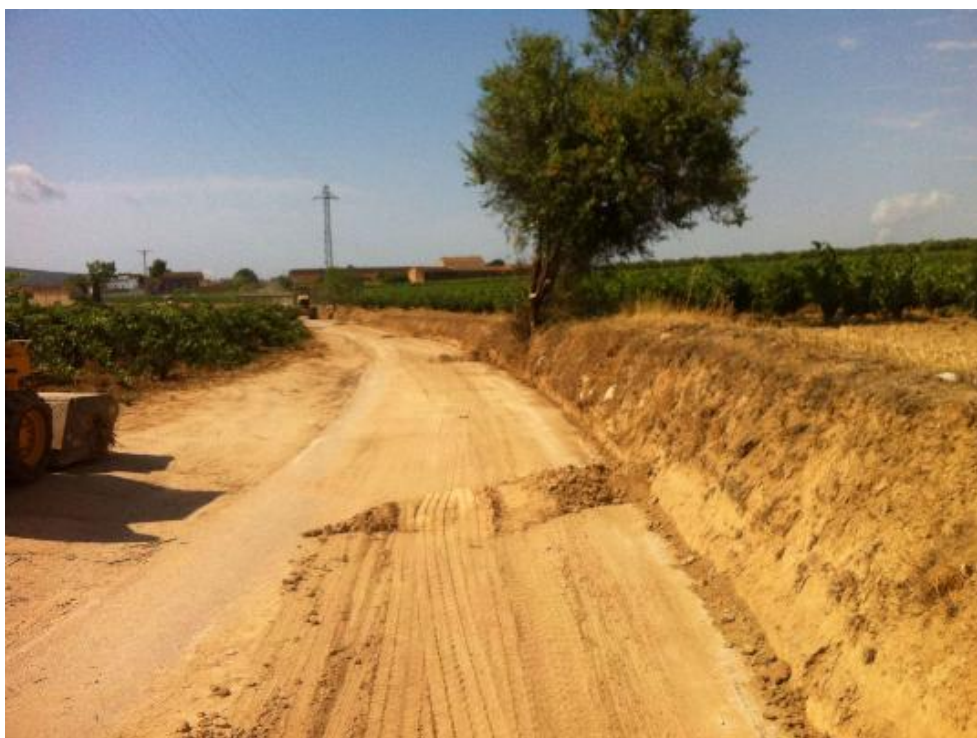
Figura 3.6 : Esempio degli effetti del transito mezzi su strade non asfaltate
