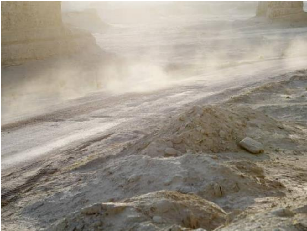
Figura 3.5: Esempio produzione di polvere da erosione cumuli ad opera del vento
