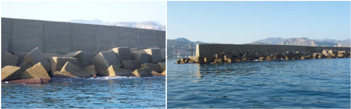
Figura 3.4 – Mantellata della diga foranea
