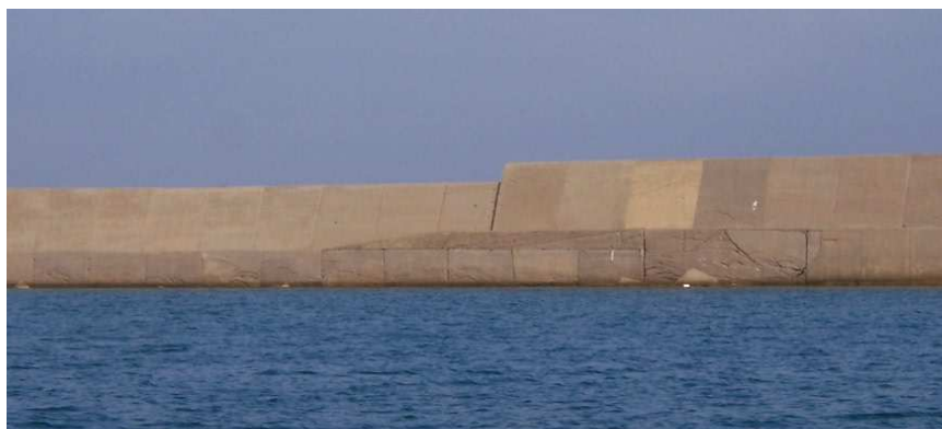
Figura 3.3 – Salti di quota lungo il molo di sopraflutto
