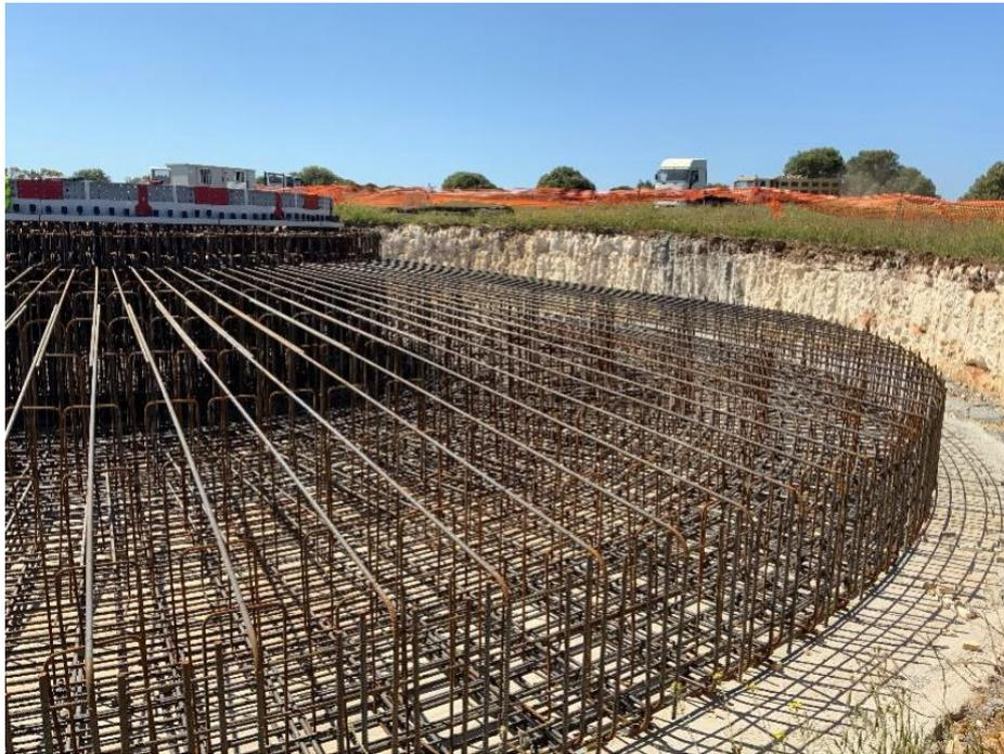
**Figura 6.5: Esempio Armatura del Plinto di Fondazione**
