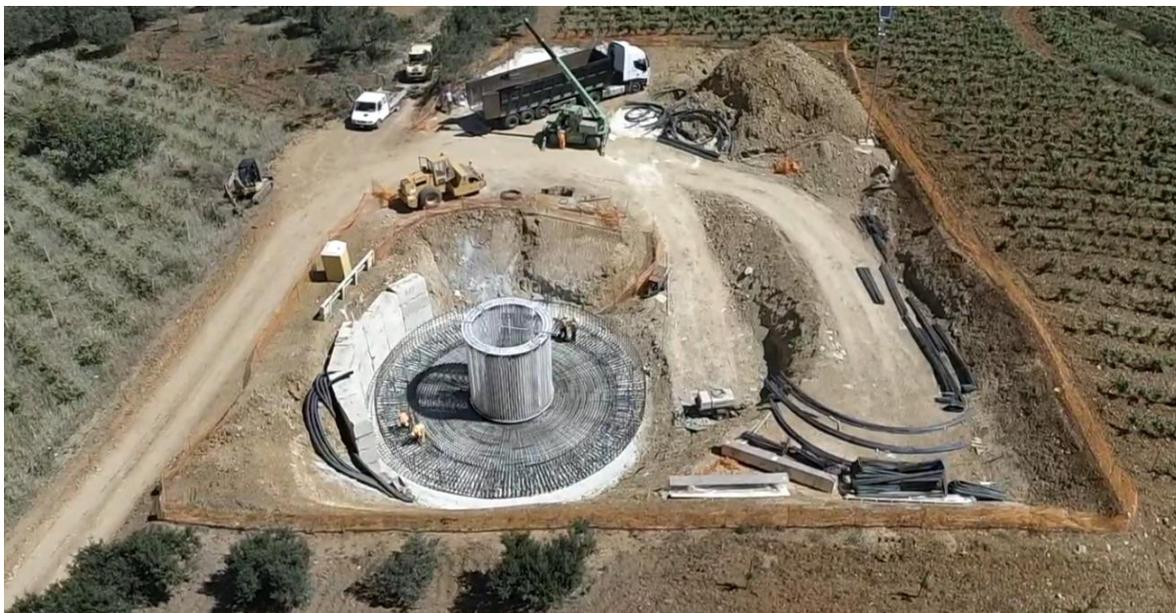
Figura 6.10: posa in opera armatura del plinto e anchor cage
