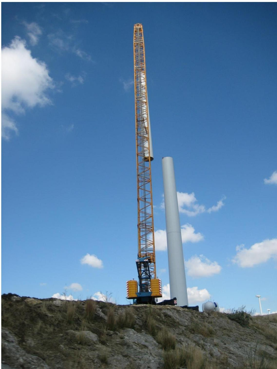
Figura 6.34: Attività di Smontaggio degli Elementi Tronco-Conici del Sostegno dell'Aerogeneratore
