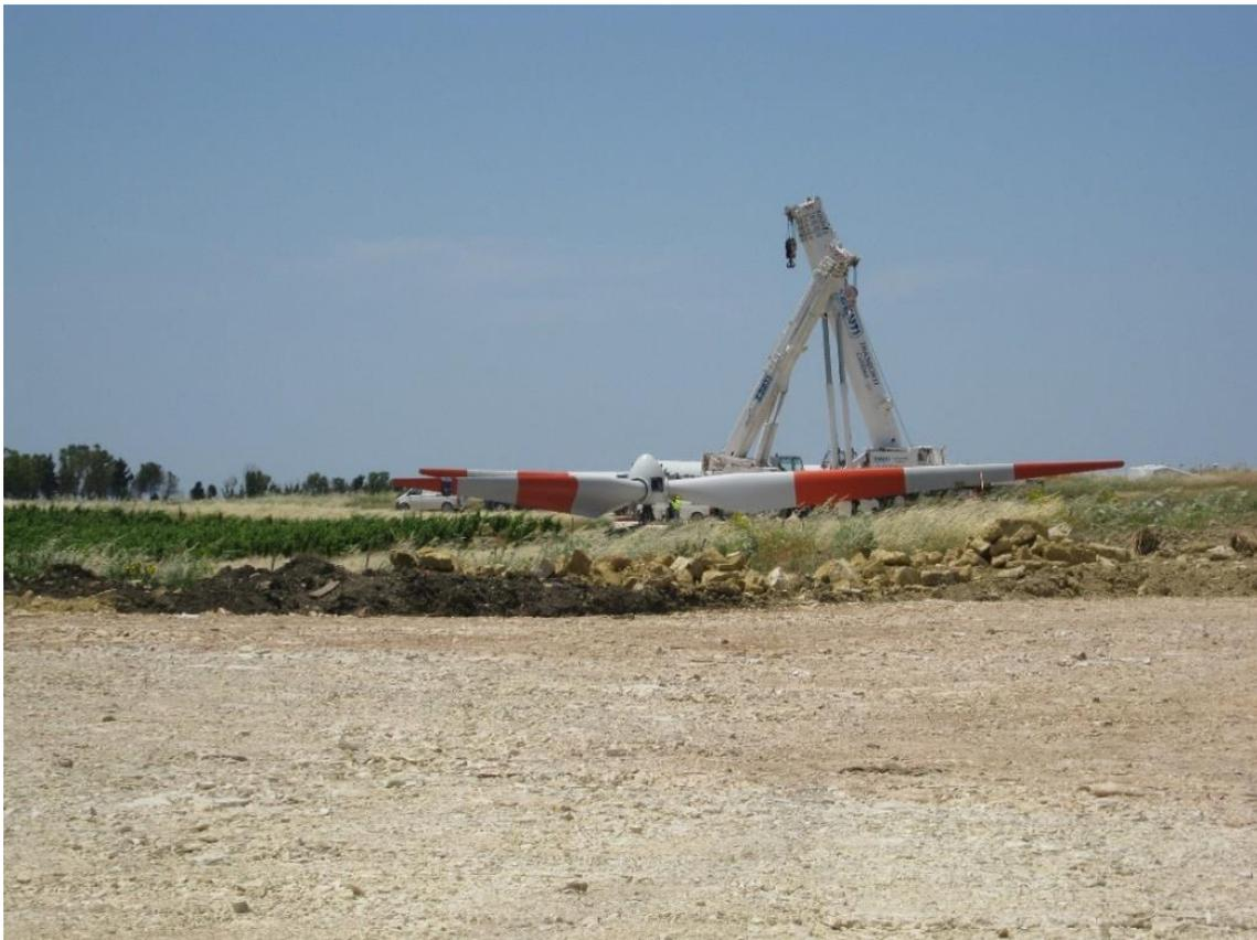
Figura 6.32: Rotore di un Aerogeneratore V52 Collocato a Terra
