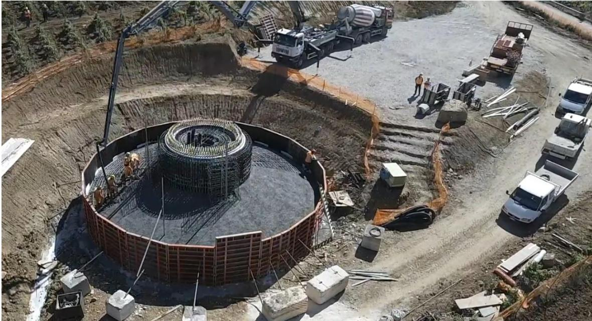
Figura 6.11: Getto del conglomerato cementizio del plinto di fondazione
