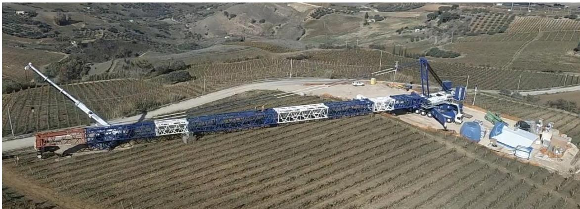
Figura 6.13: Assemblaggio completato del braccio tralicciato della gru principale
