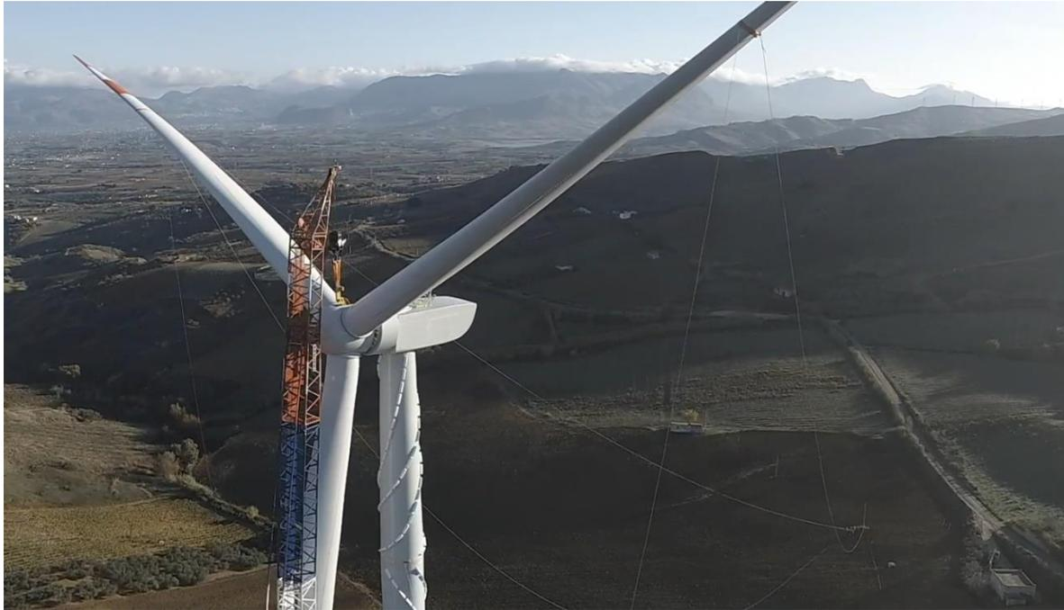
Figura 6.17: Collocazione in opera del rotore
