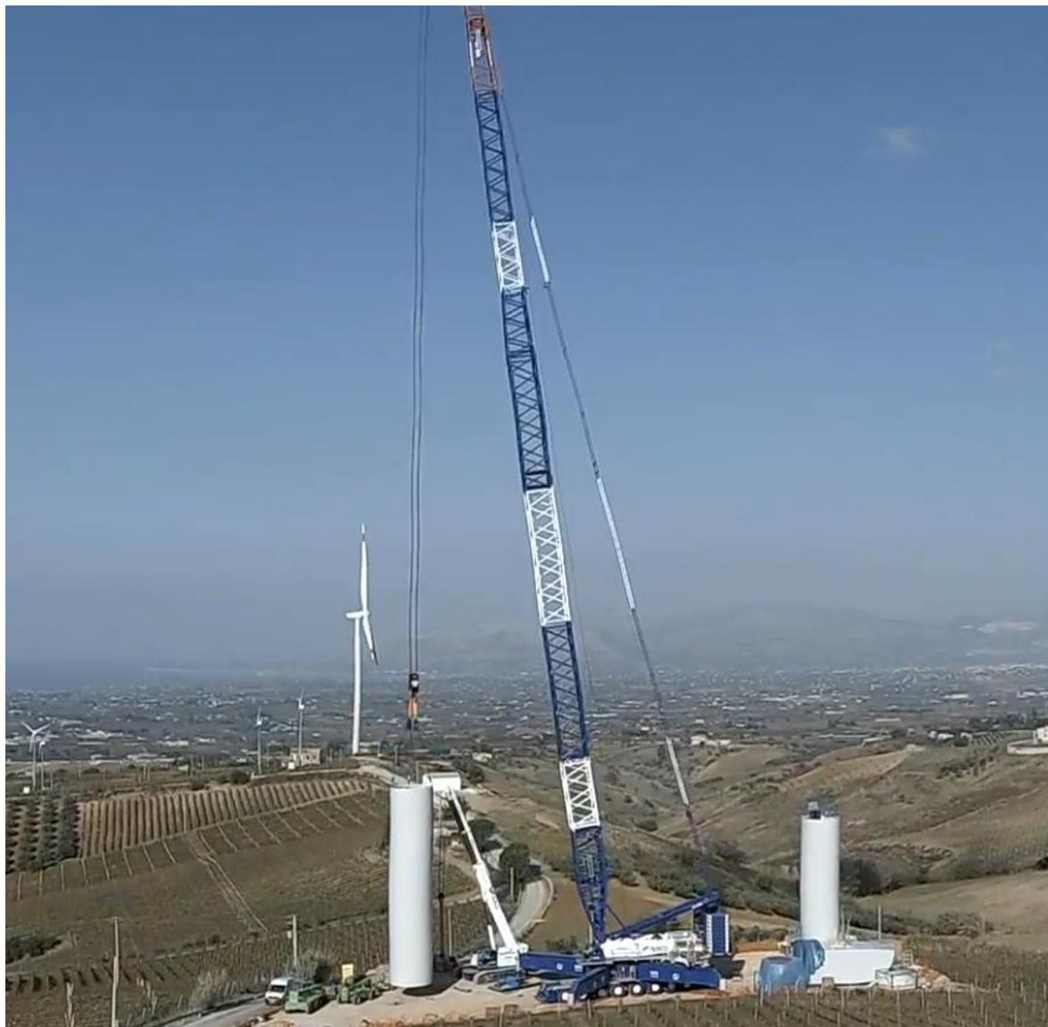
Figura 6.15: Collocazione in opera degli elementi troncoconici in acciaio costituenti il sostegno dell'aerogeneratore
