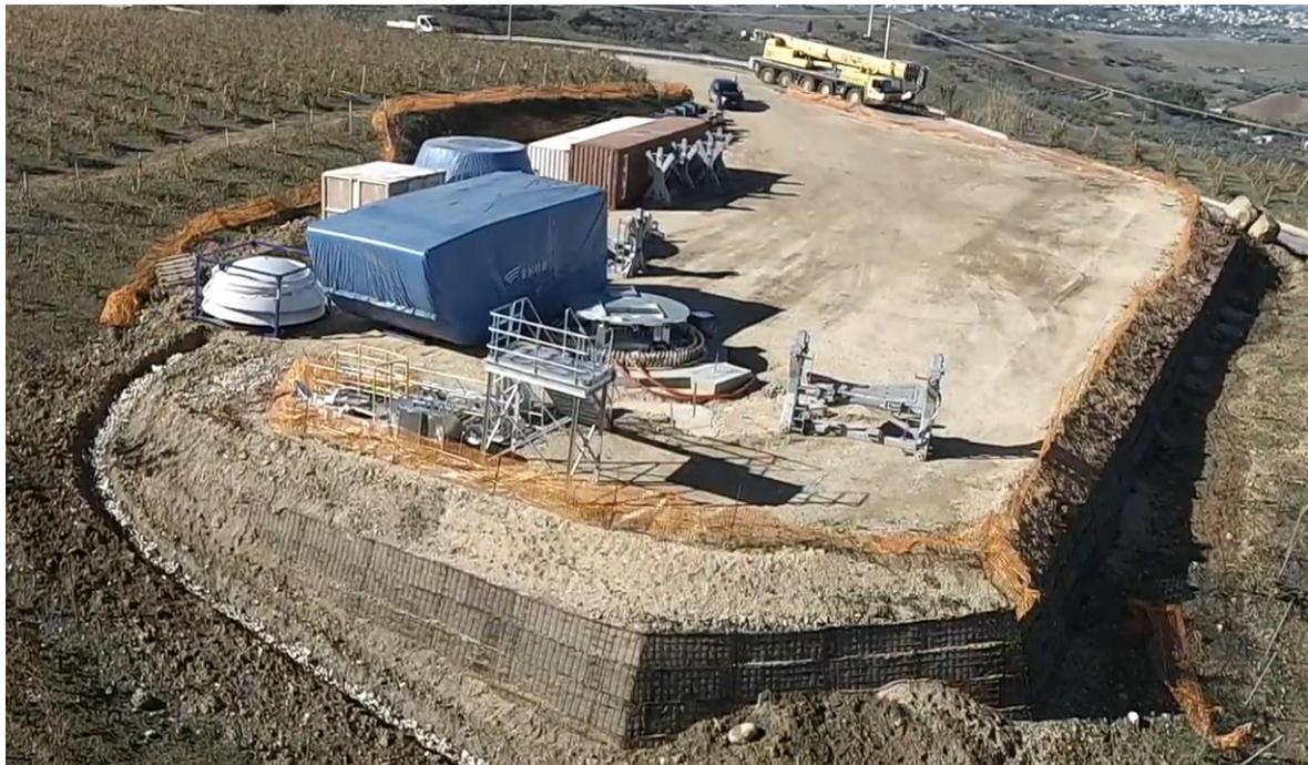
Figura 6.12: Rinfianco e rinterro del plinto completato e piazzola pronta per il montaggio
