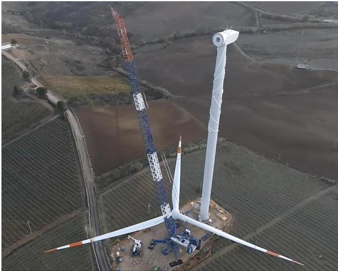
Figura 6.16: Navicella in opera sul sostegno troncoconico in acciaio e rotore assemblato a terra
