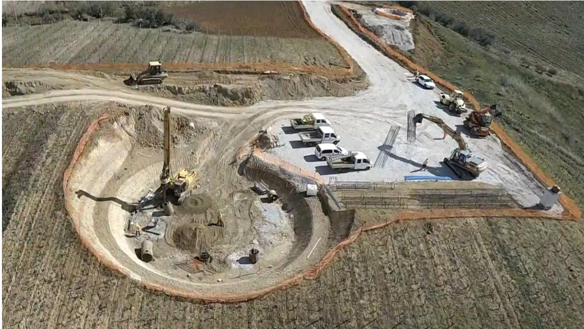
Figura 6.9: Piazzola per lo stazionamento dei mezzi e scavo di sbancamento per il plinto
