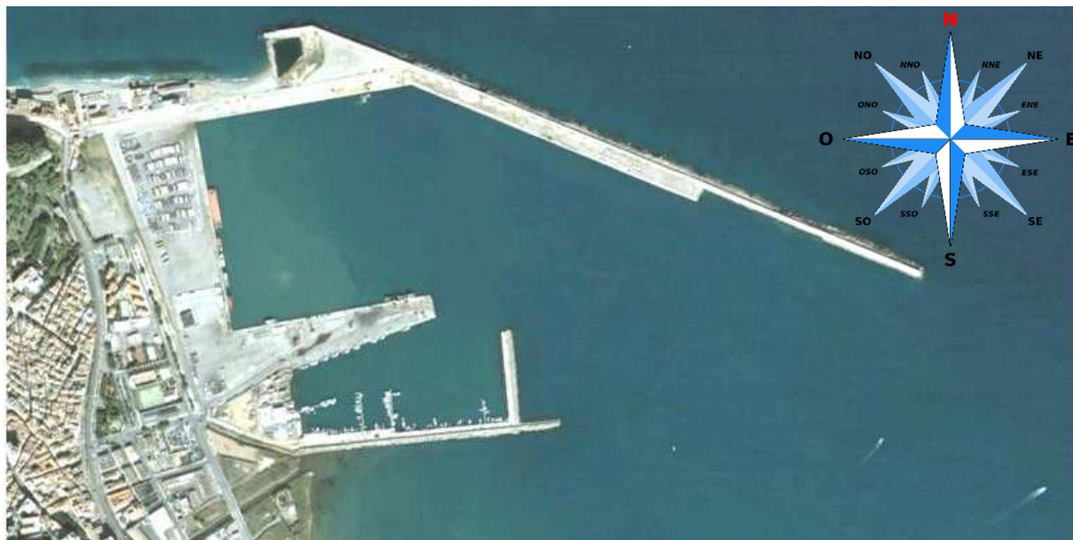
Figura 3.2 – Inquadramento di dettaglio del porto di Termini Imerese
