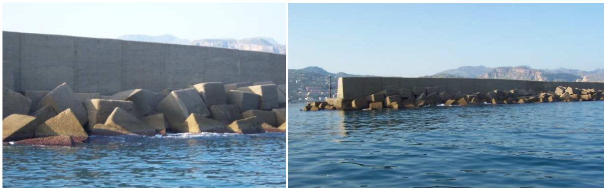
Figura 2.6 – Mantellata della diga foranea
