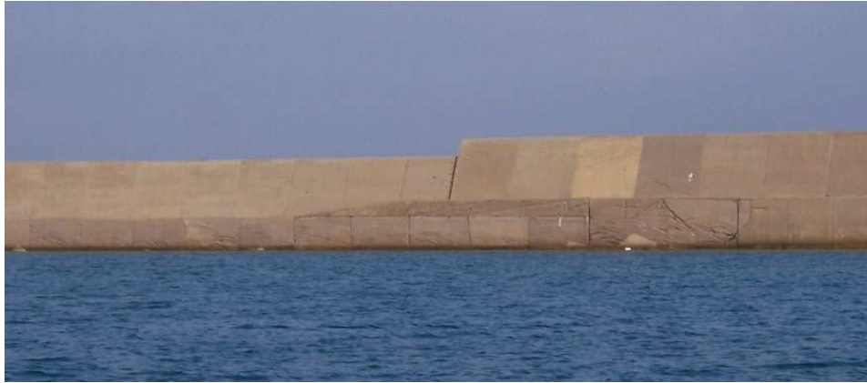
Figura 2.5 – Salti di quota lungo il molo di sopraflutto
