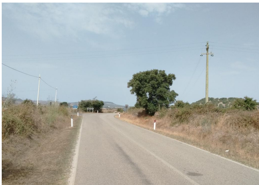
Figura 4.3 Linea aerea di media tensione MT05
