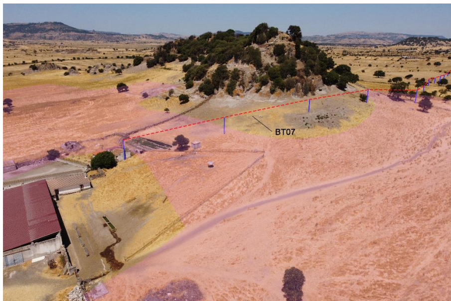
Figura 3.10 Linea aerea di bassa tensione BT07 (segnalata in rosso)
