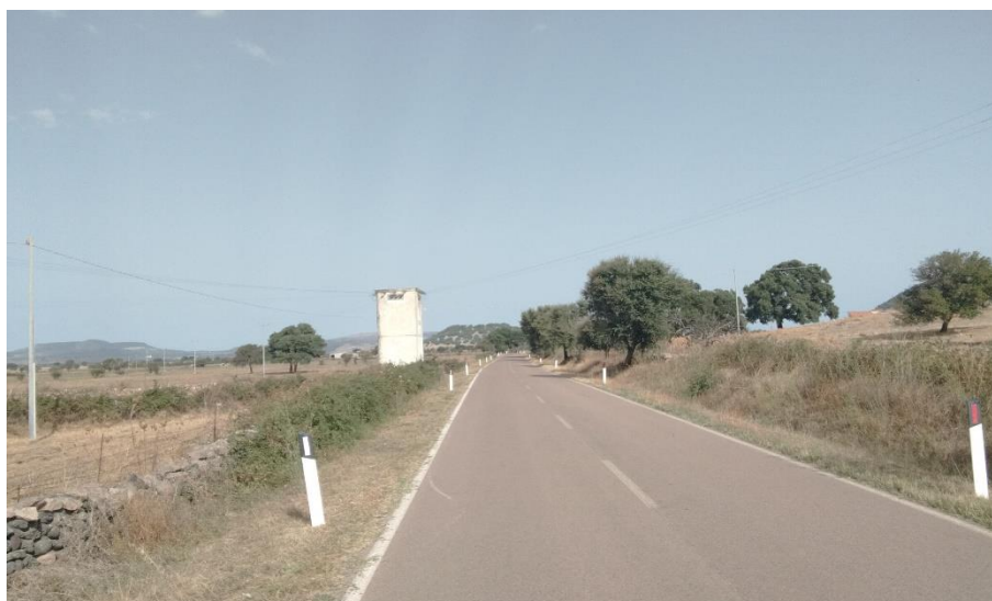
Figura 4.9 C Linea aerea di media tensione MT06
