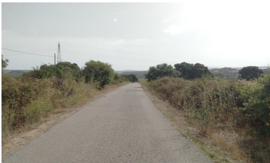
Figura 4.6 Linea aerea di alta tensione AT01
