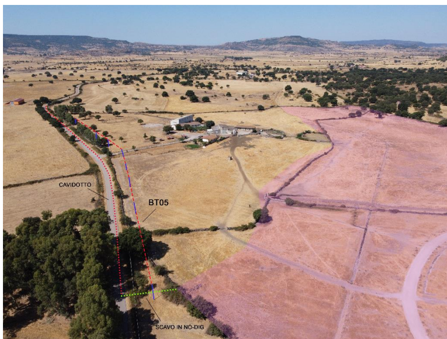
Figura 3.7 Linea aerea di bassa tensione BT05
