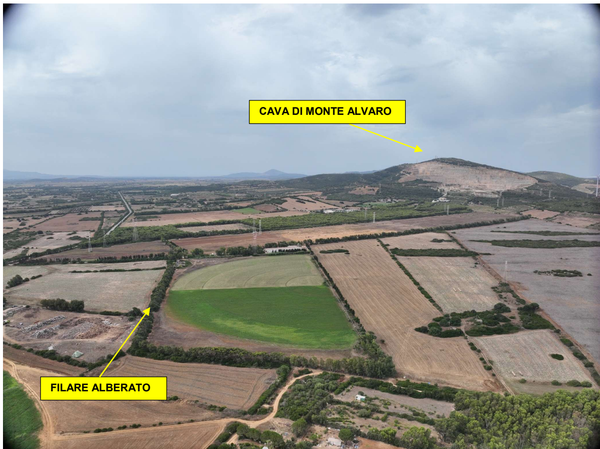
Figura 10: Stato di fatto - vista da nord
