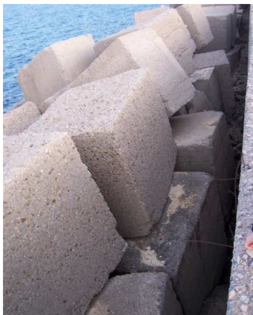
Figura 3.3. Particolare della mantellata
