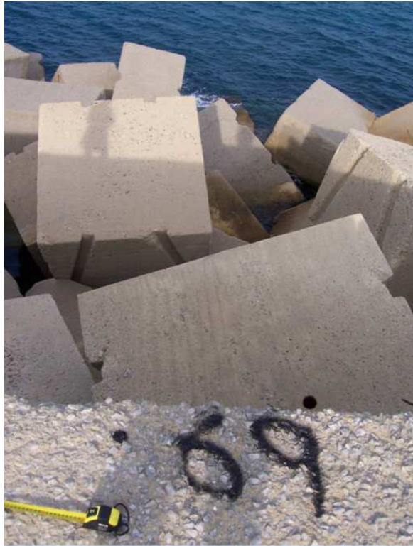
Figura 3.4. Sezione trasversale tipo della mantellata in corrispondenza di una delle sezioni rilevate.
