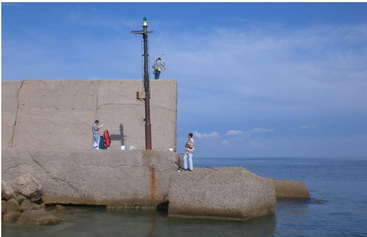
Figura 3.6. Fase di picchettamento GPS del muro paraonde.
