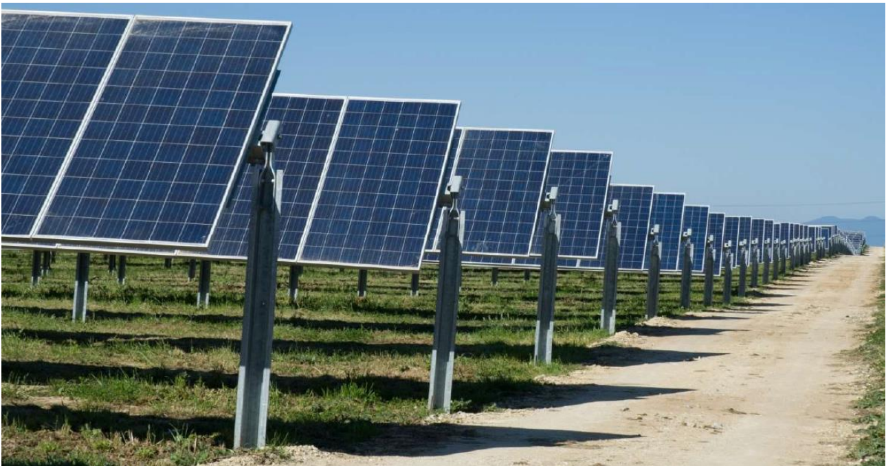
Figura 1 - immagine esemplificativa di inseguitori mono-assiali in configurazione 1-P
