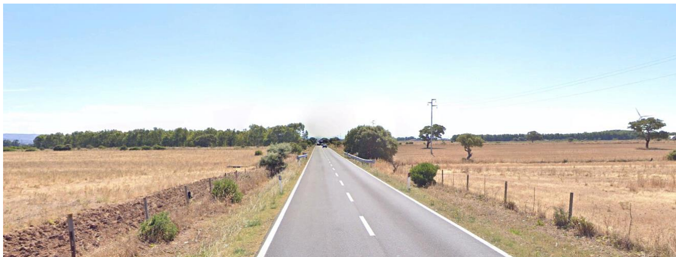
Figura 2-7: Panoramiche dell'area di intervento dalla SS 197 - Stato di fatto
