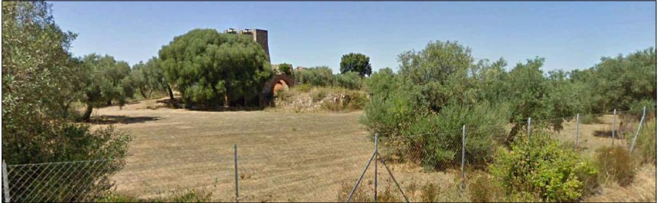
PUNTO 05 - Post operam
