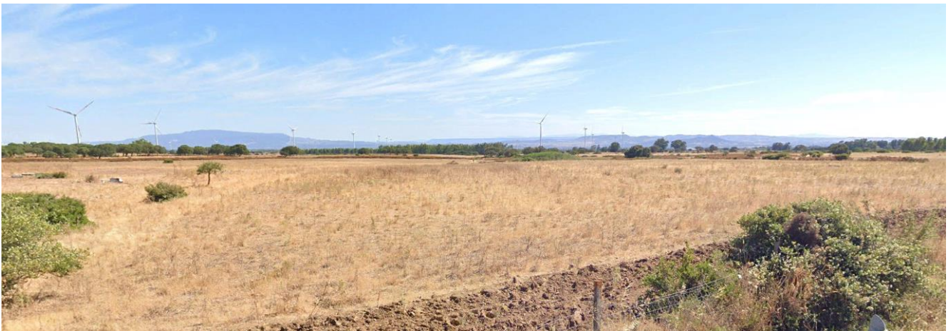
Figura 7-3: Impianti eolici esistenti nell'area di progetto
