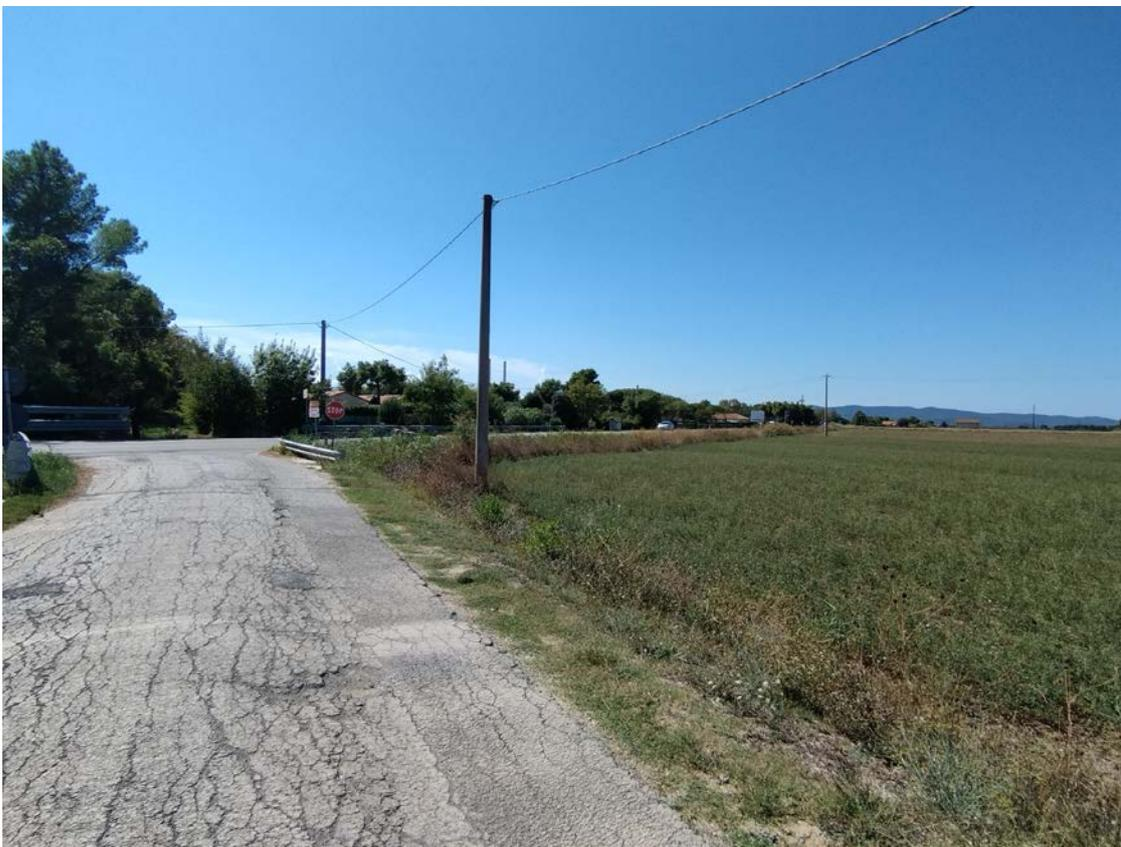
*Viabilità in conglomerato bituminoso esistente in pessimo stato*
