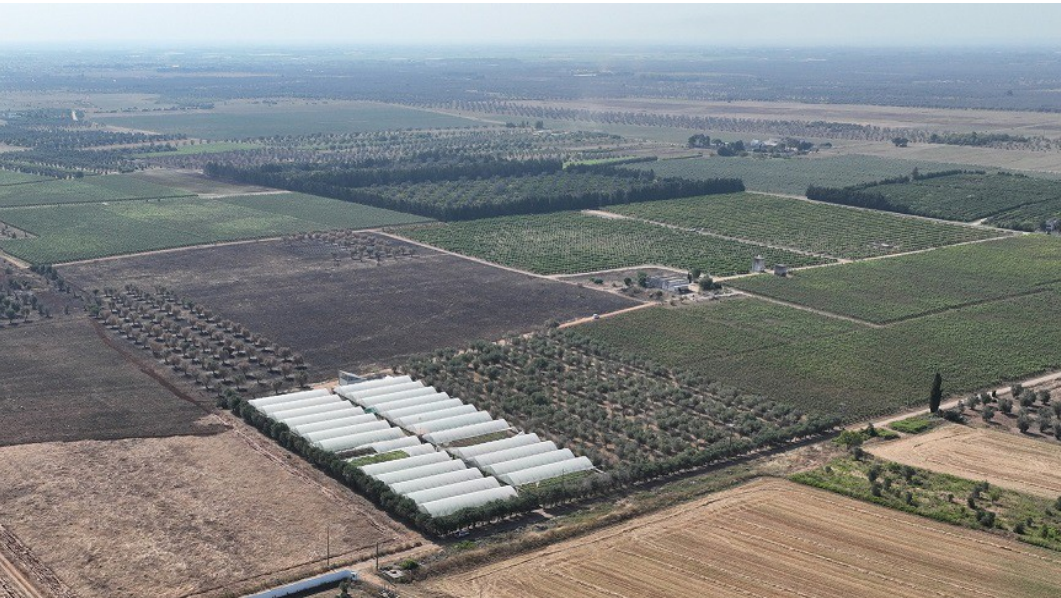
REPORT FOTOGRAFICO AREA – IMPIANTO “CERFEDA” - Veglie (LE)
