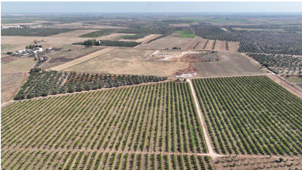
REPORT FOTOGRAFICO AREA – IMPIANTO “CERFEDA” - Veglie (LE)
