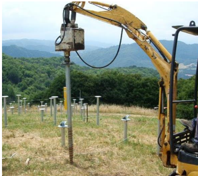
Figura 2: Sistema di ancoraggio al suolo denominato "T-Block"
