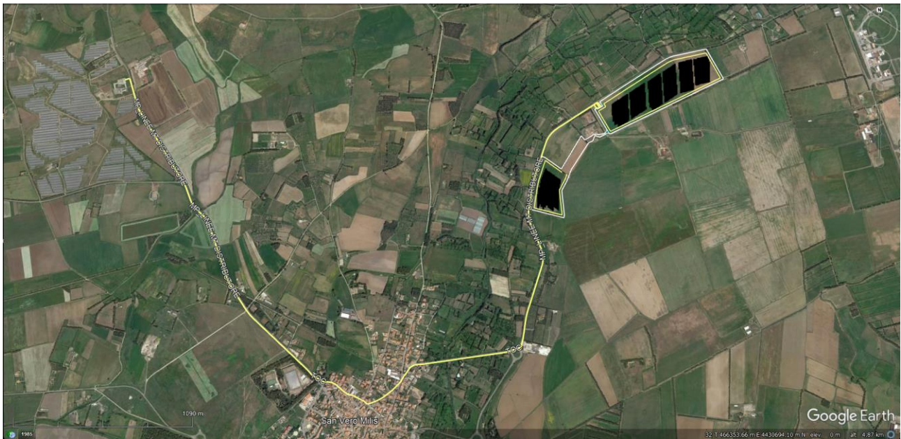
Figura 3. Lay-out dell’Impiantistica Fotovoltaica e il percorso del cavidotto (linea gialla) del Progetto Agrivoltaico “SAS MURTAS” tra Milis e San Vero Milis (OR).
