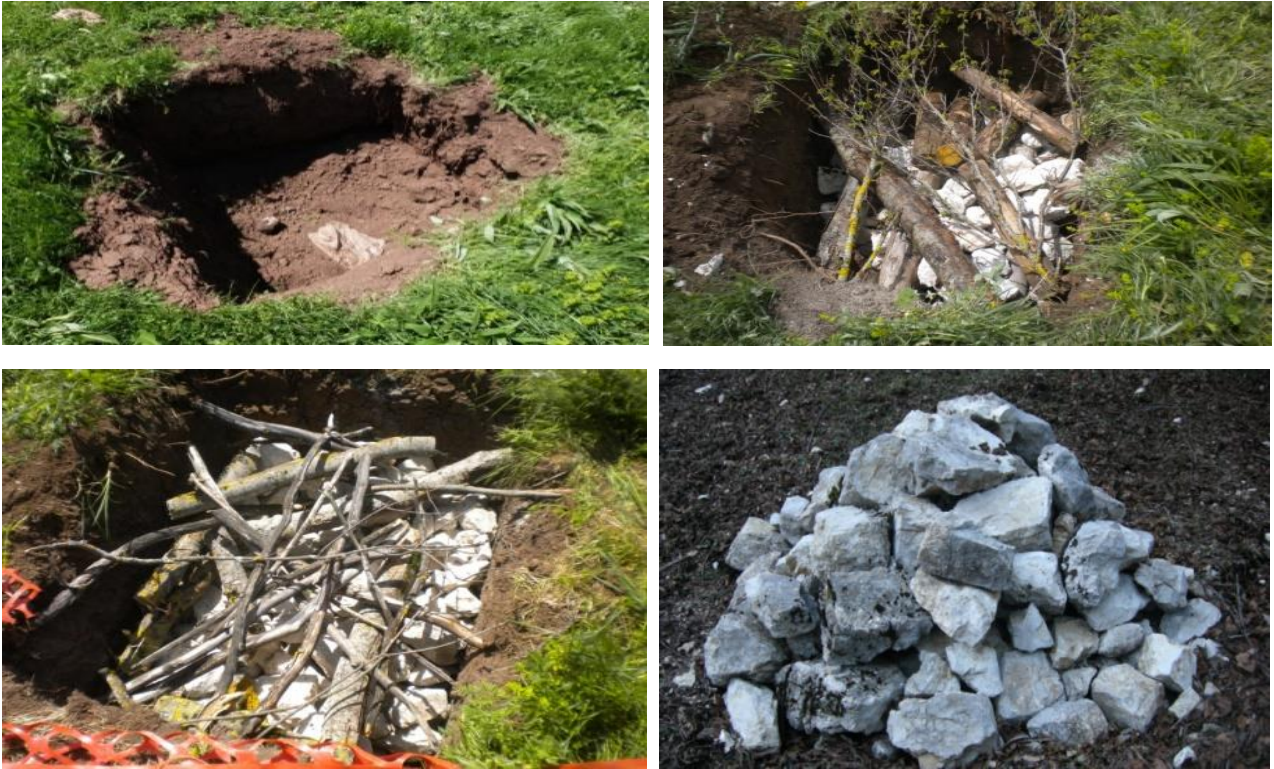
Figura 29. Le fasi di realizzazione di un rifugio semi-interrato per piccoli animali terricoli. Si tratta di una mitigazione efficace nei casi di spietramento a fini agronomici dei terreni agricoli.
