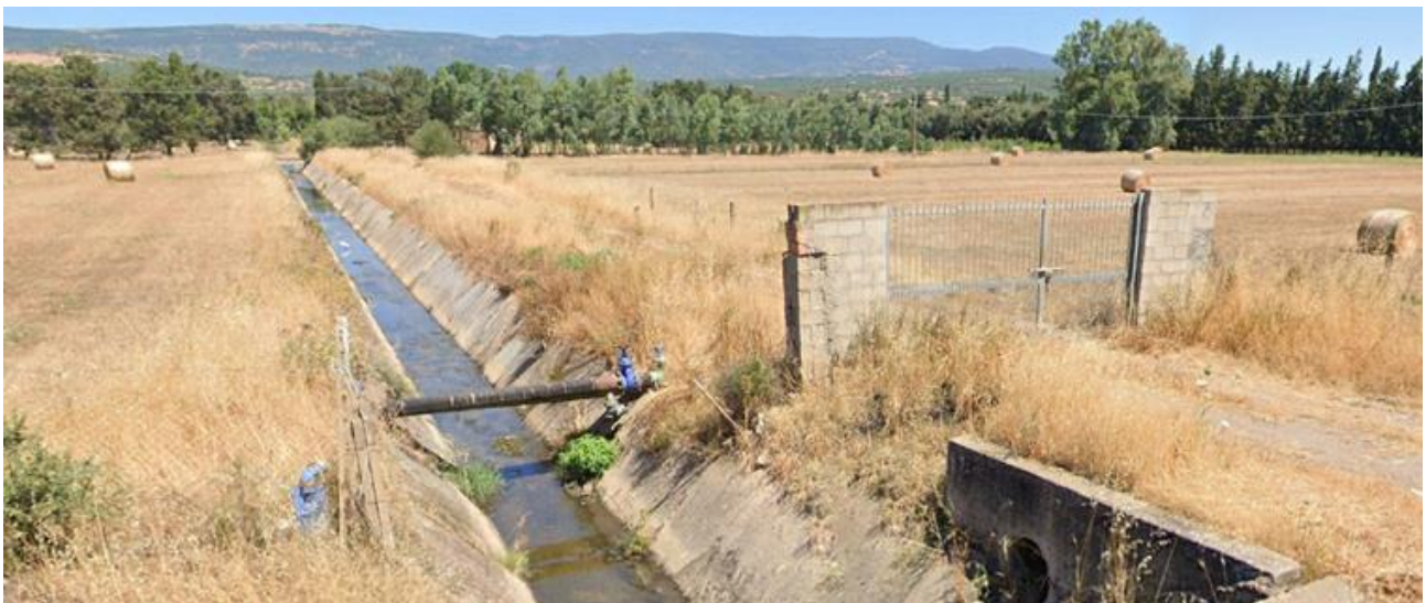
Figura 25. La canaletta irrigua in arrivo ai terreni di Progetto.
