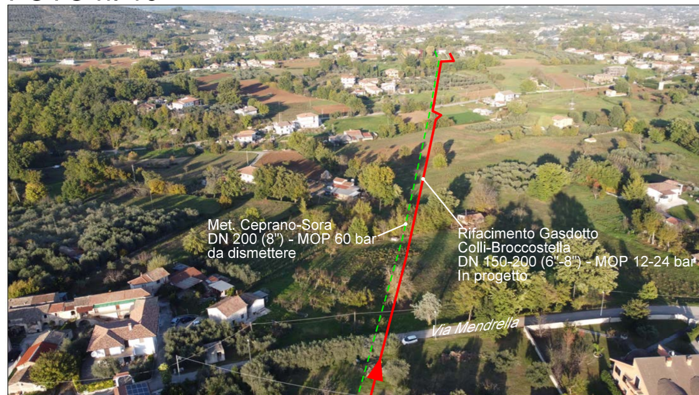
Percorrenza su aree agricole e parallelismo alla condotta da dismettere
