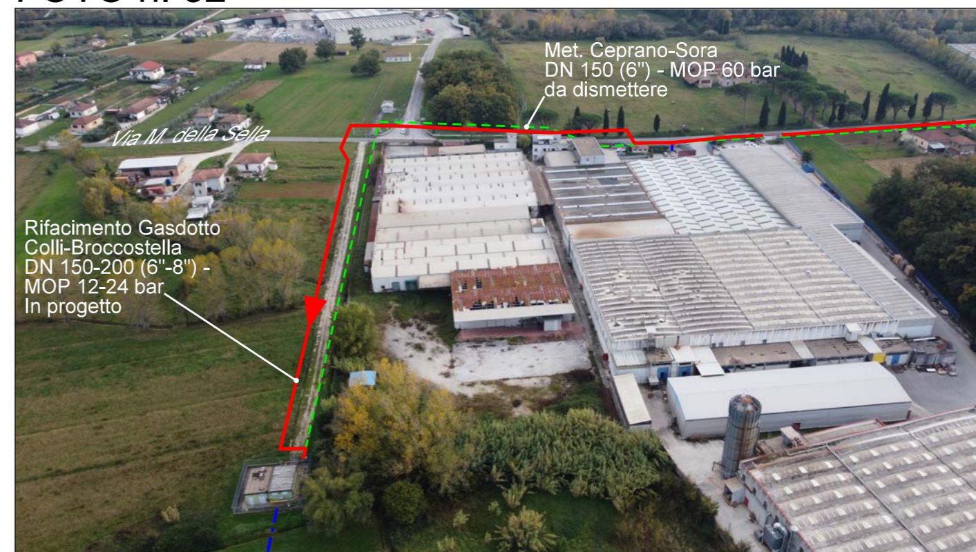
Panoramica del nuovo tratto con l'attraversamento di Via Madonna della Stella e ricollegamento all'impianto di Broccostella
