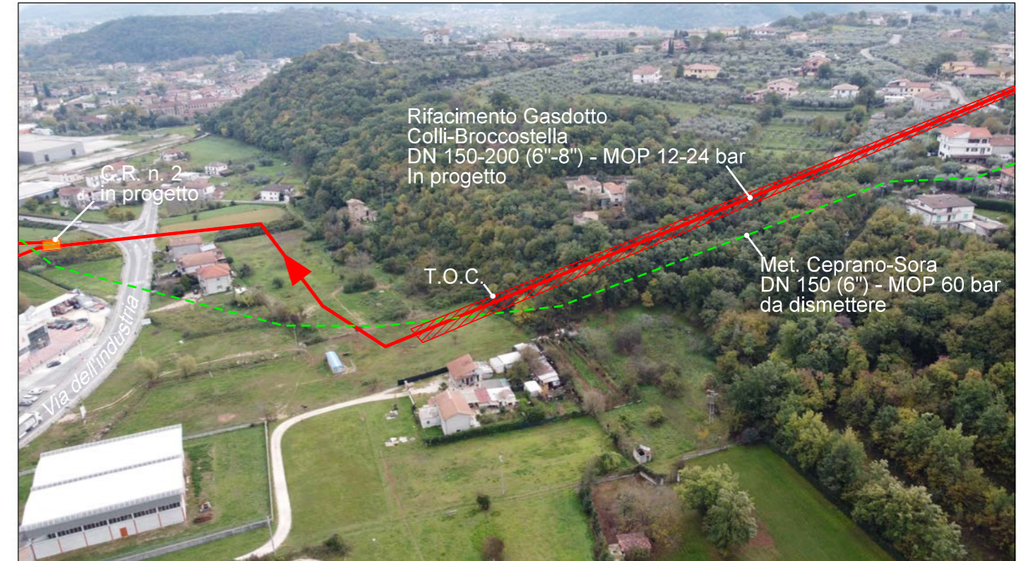
Panoramica del nuovo tratto posato tramite tecnologia trenchless della Trivellazione Orizzontale Controllata (TOC) sul versante con elevata inclinazione ed occupato da bosco e oliveto
