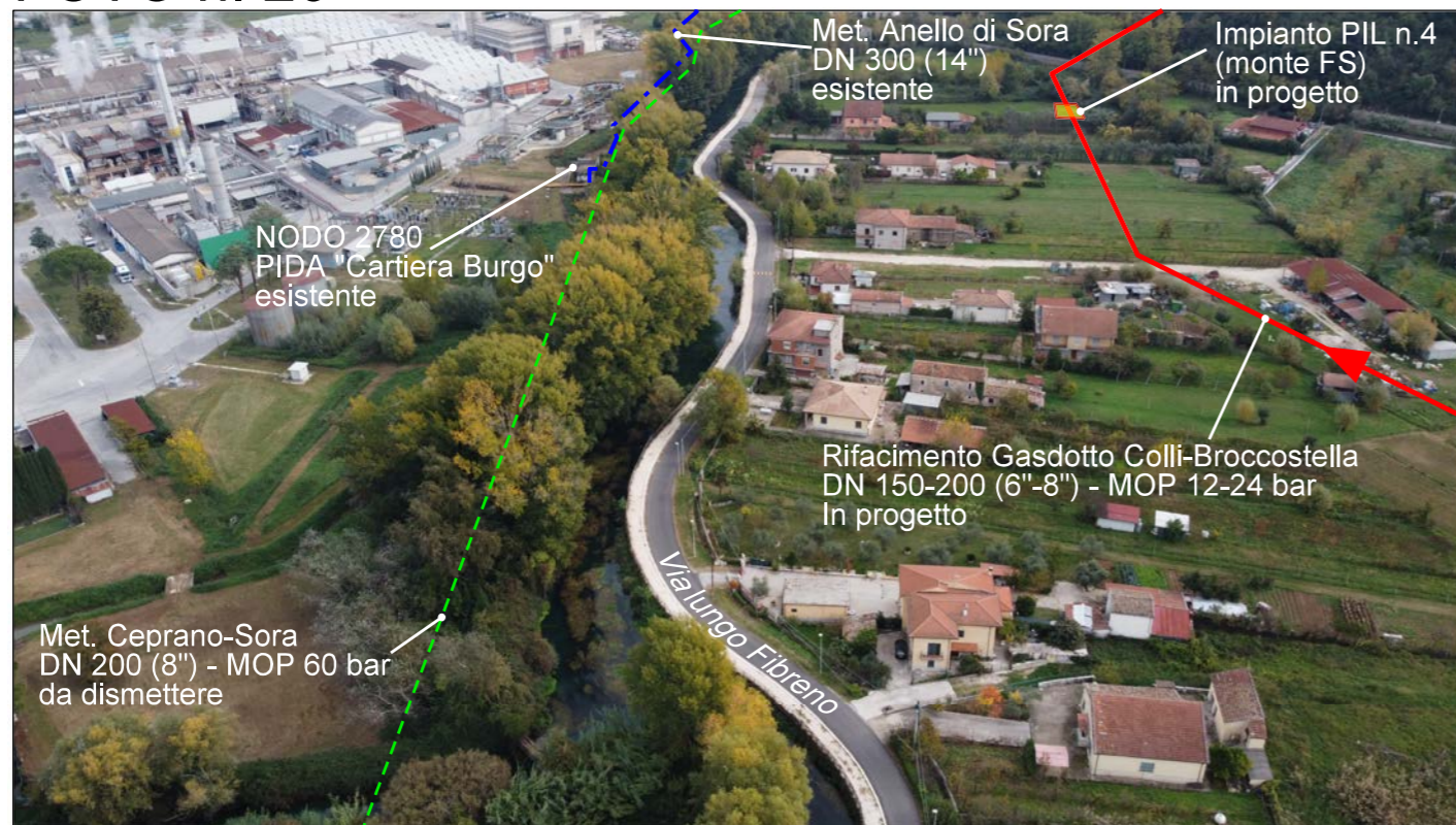
Panoramica del nuovo tratto con percorrenza su aree agricole e nuovo impianto PIL n.4
