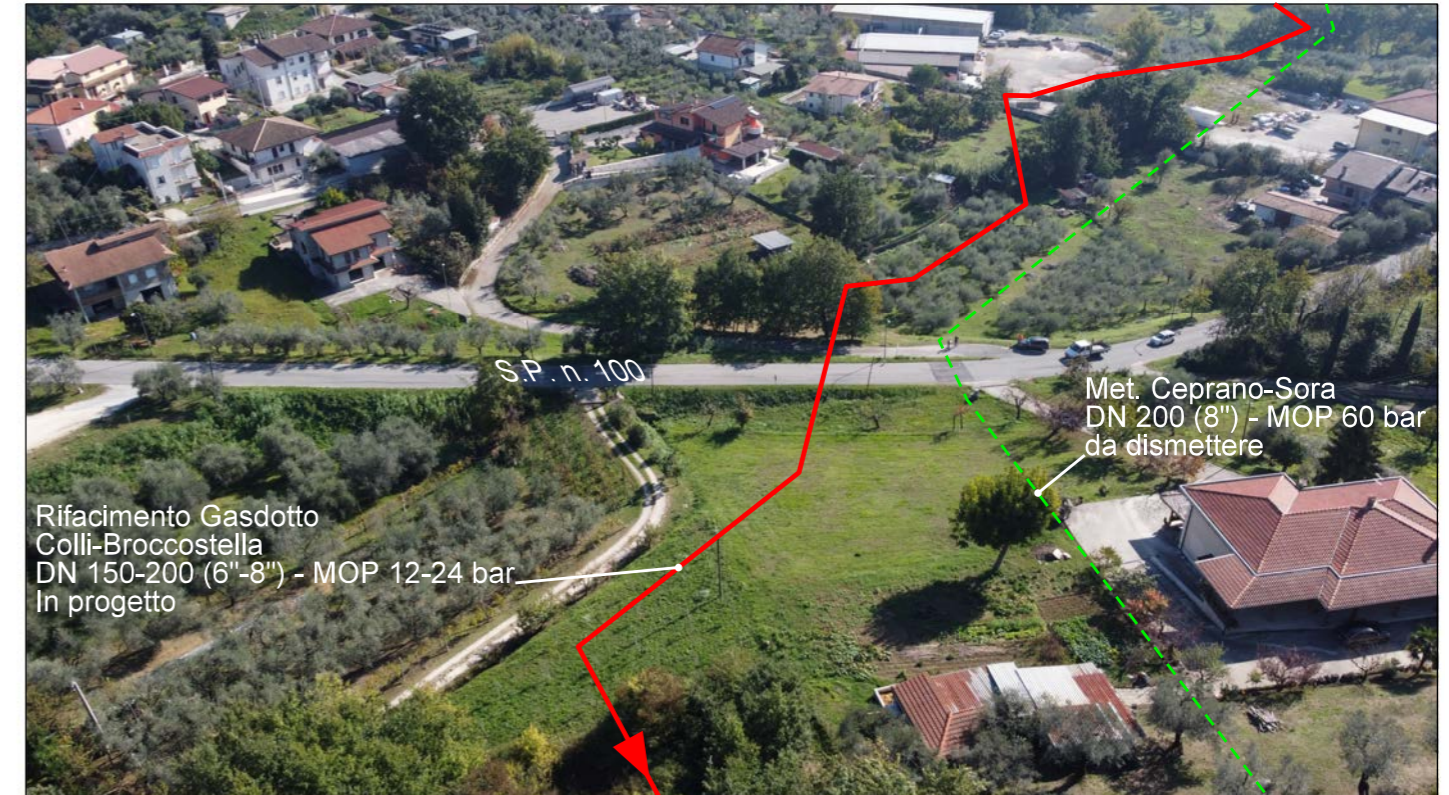
Panoramica del nuovo tratto in attraversamento di via S.P. n.100 con modalità spingitubo
