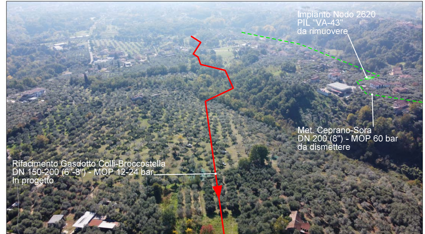
Panoramica del nuovo tratto di gasdotto che risale un leggero versante con presenza di olivi.
