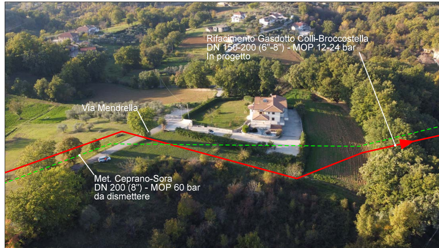
Panoramica del nuovo tratto in attraversamento di via Mendrella con modalità spingitubo
