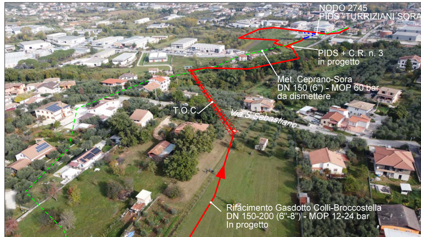
Panoramica del nuovo tratto co l'attraversamento in T.O.C. di area boscata e sullo sfondo andamento condotte in prossimita' del distributore "Turriziani"
