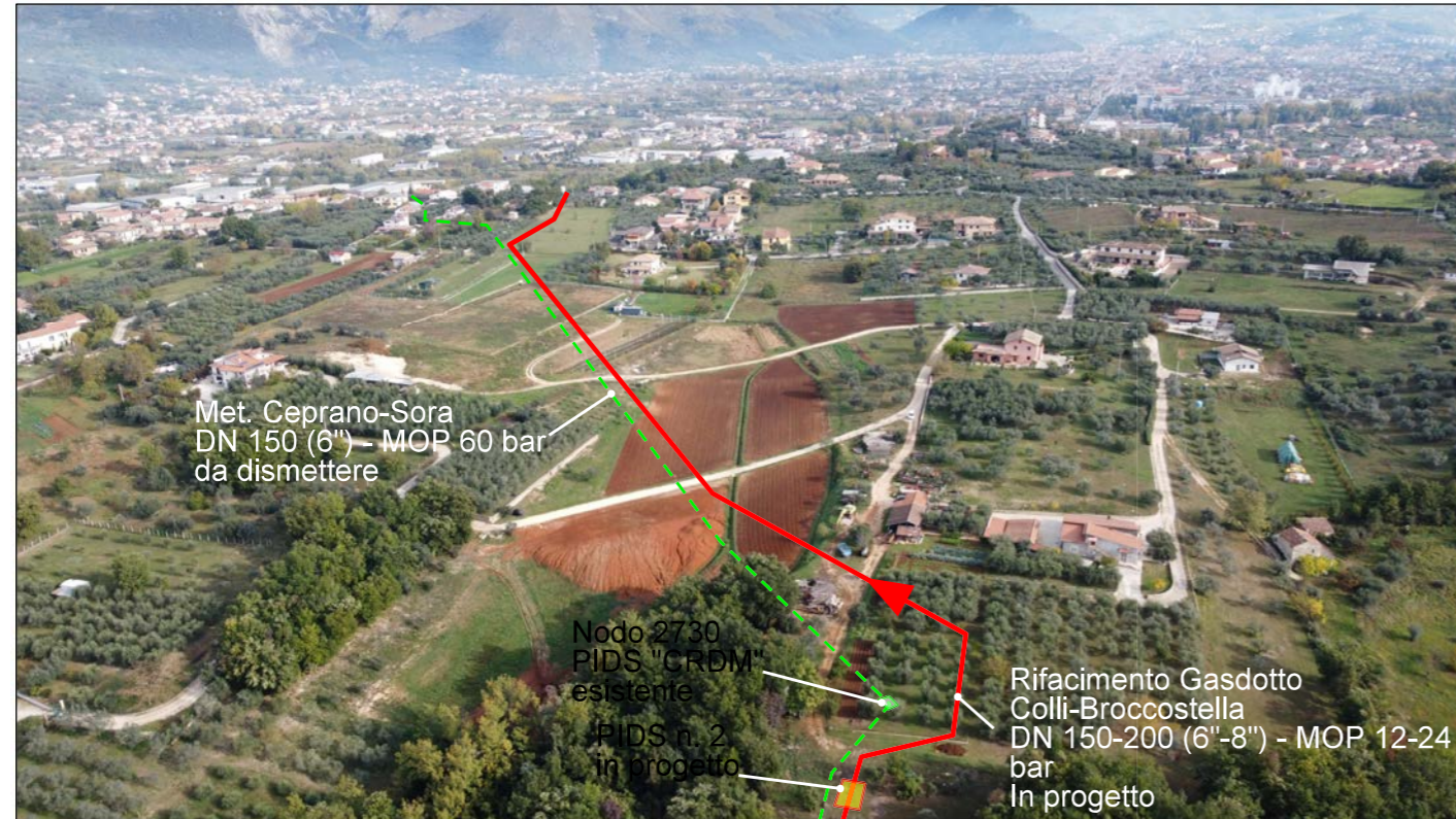
Panoramica del nuovo tratto con ubicazione PIDS n.2 e percorrenza su area agricola lontana da fenomeni franosi
