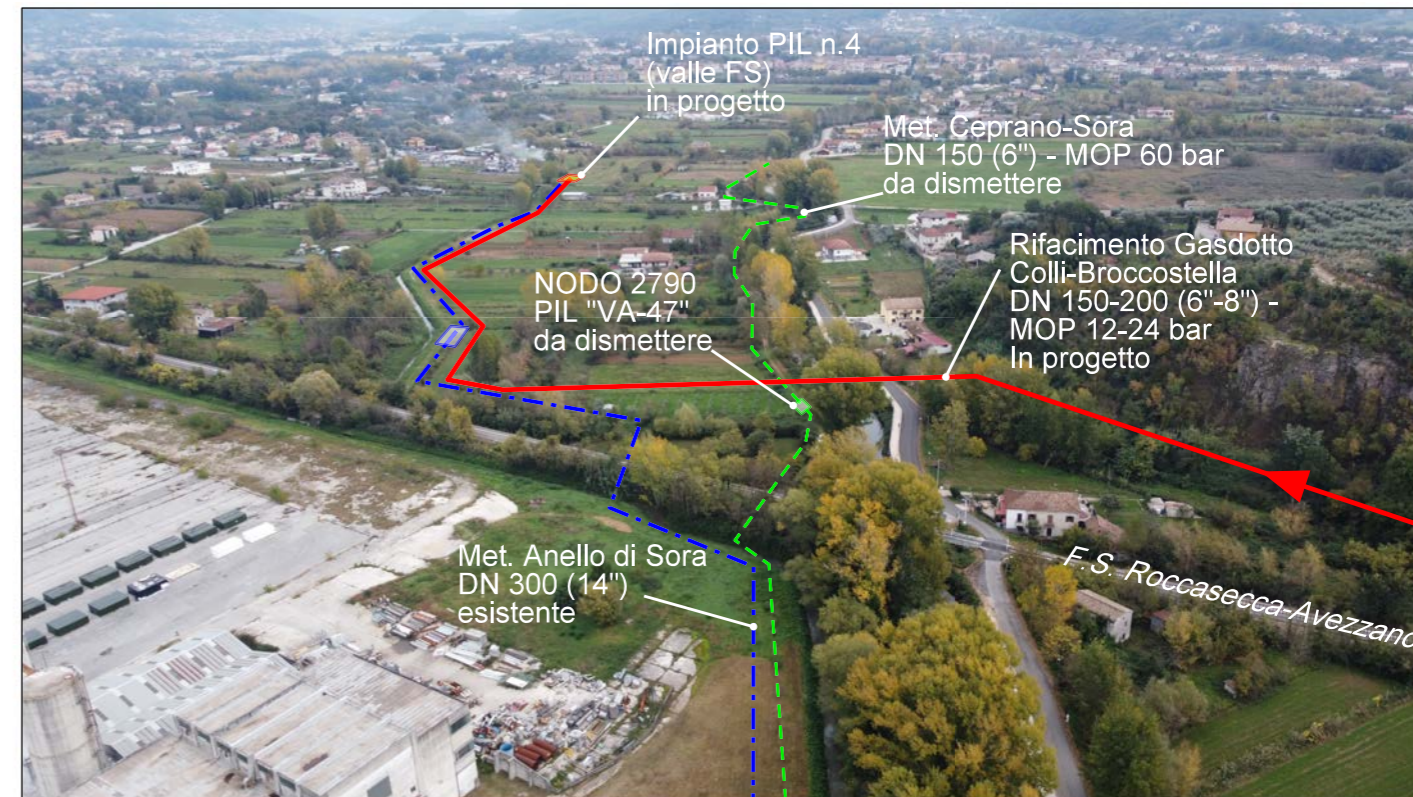
Panoramica del nuovo tratto con l'attraversamento in spingitubo del Fiume Fibreno e parallelismo con Met. Anello di Sora DN 150 (6'')-MOP 60 bar
