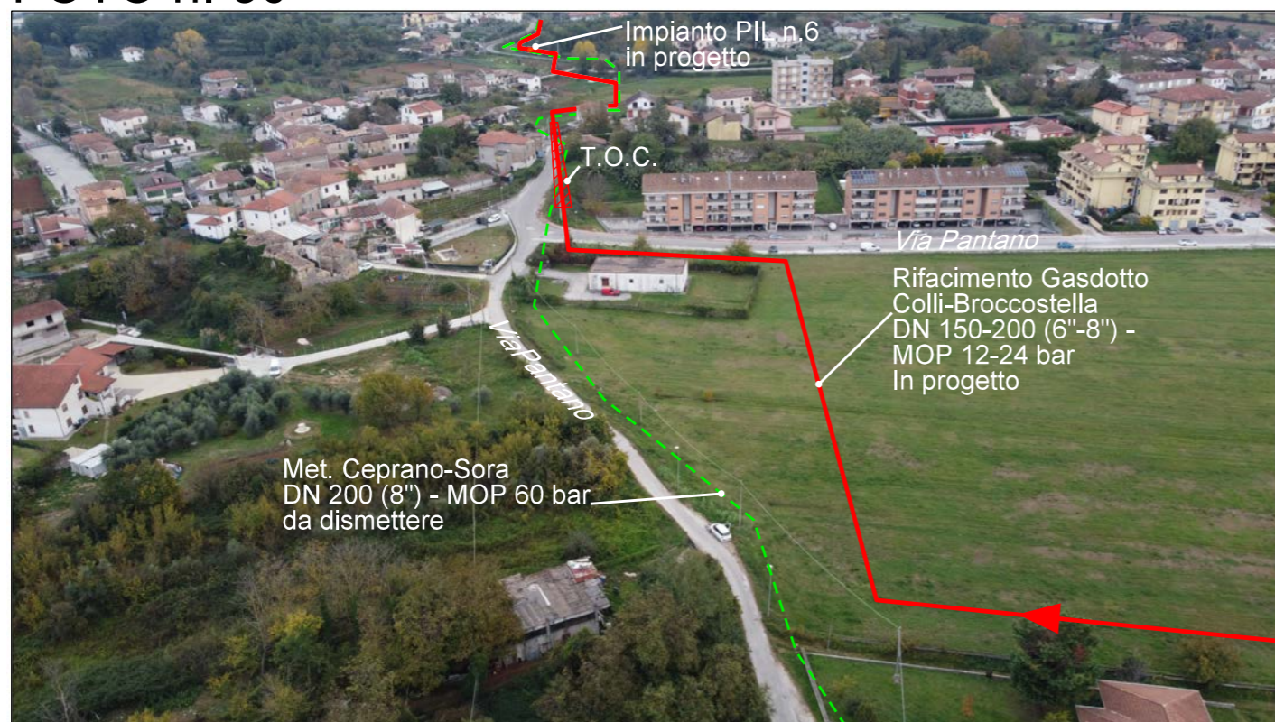
Panoramica del nuovo tratto con l'attraversamento in T.O.C. di via Bonomi e sullo sfondo il nuovo Impianto PII n.6
