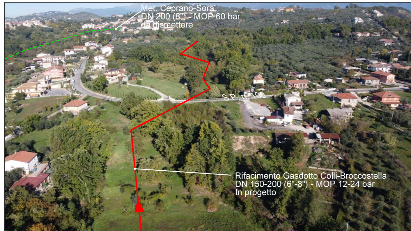
Percorrenza su terreni agricoli ed attraversamento della S.P. n.100 tramite trivella spingitubo
