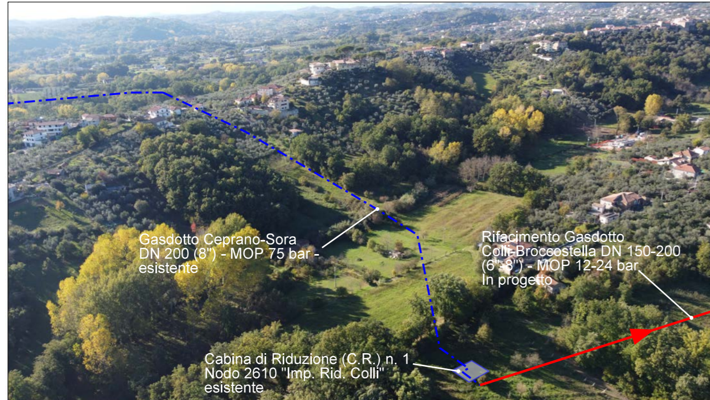
Panoramica del punto di partenza del Gasd. Rif. Gasd. Colli-Broccostella DN 150-200 (6"-8") - MOP 12-24 bar oggetto di rifacimento
