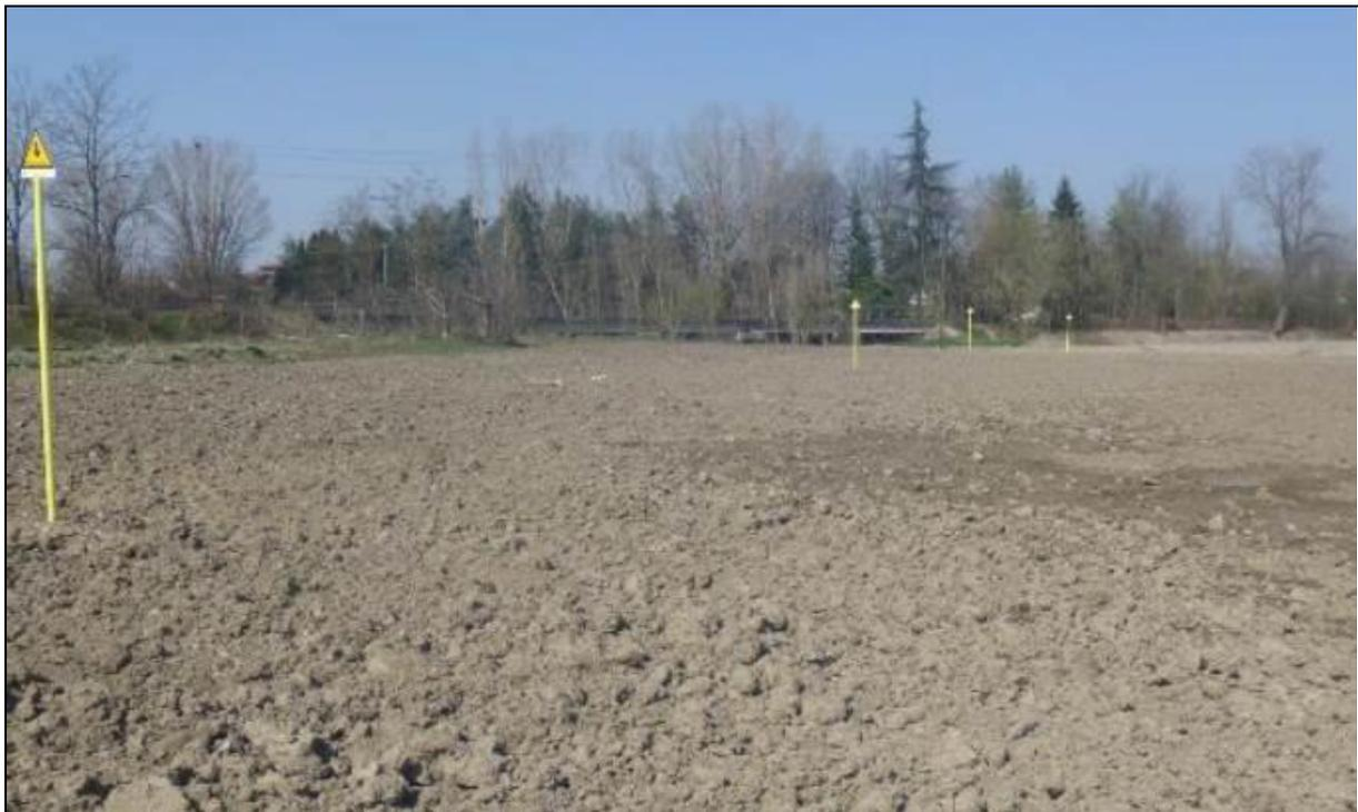
**Figura 9/A – Pista lavori, su terreno agricolo, a ripristini ultimati; si nota la disposizione delle paline segnaletiche su metanodotto in esercizio**
