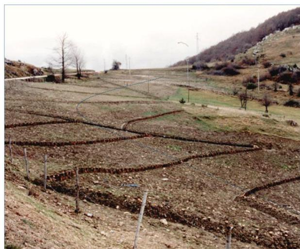
Figura 9.1/A – Schema ed esempio di fascinata
