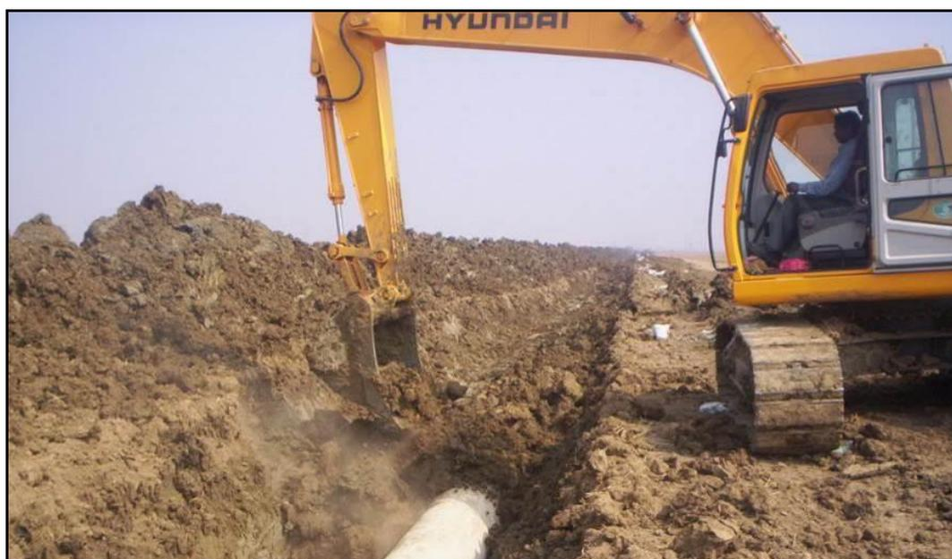
**Figura 8.1.9/A - Rinterro della condotta**
