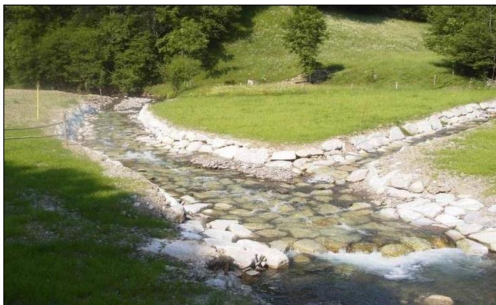
**Figura 9.1/F – Esempio di rivestimento in massi con platea di fondo**
