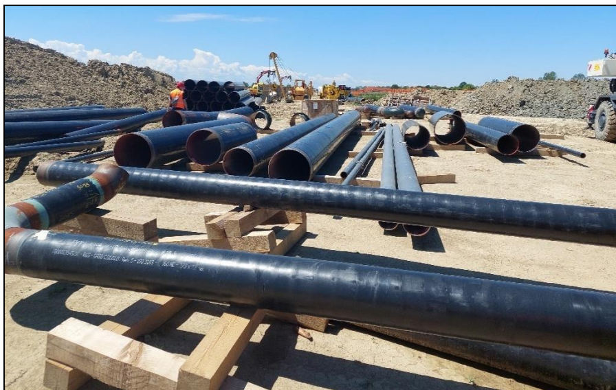
Figura 3-B: Piazzola di accatastamento tubazioni
