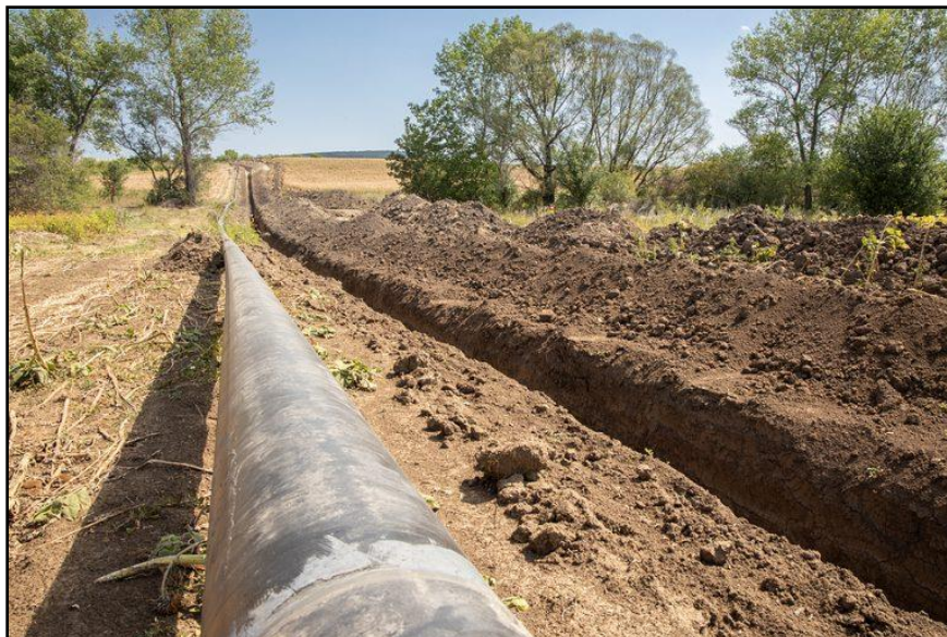
Figura 3-A: Scavo della trincea
