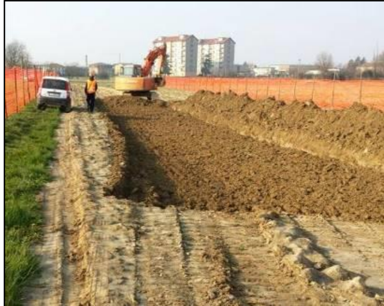
Figura 3-C: Apertura della pista di lavoro
