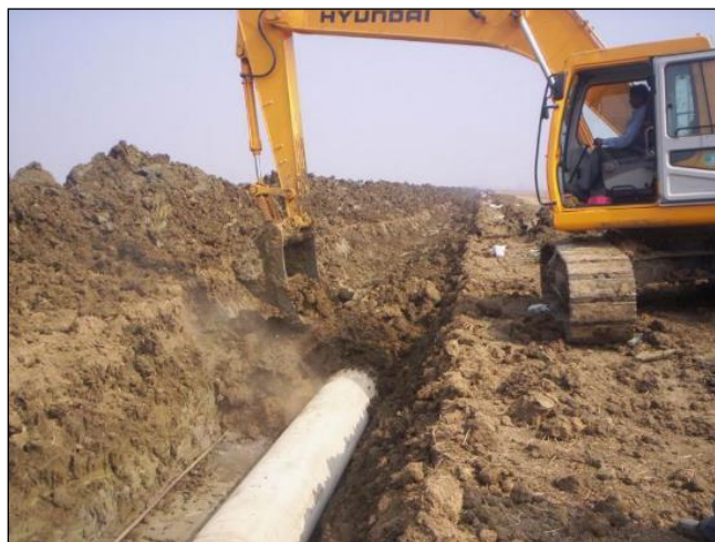
Figura 3-F: Rinterro della condotta
