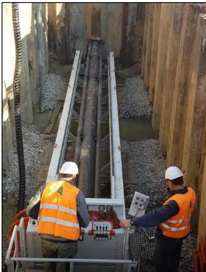
Figura 3-J: Esecuzione di trivellazione spingitubo
