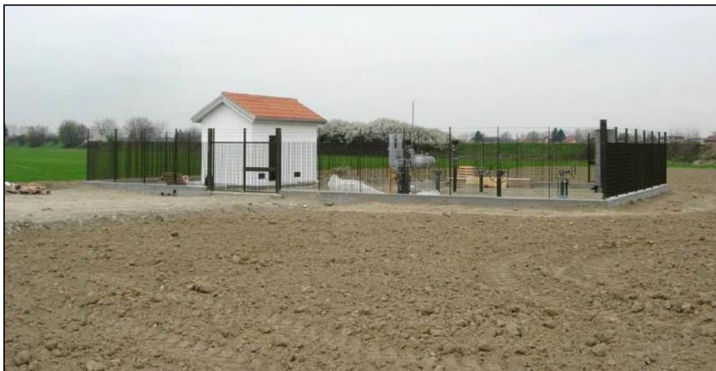
Figura 3-M: Installazione tipo impianti di linea con pannelli in grigliato di ferro verniciato
