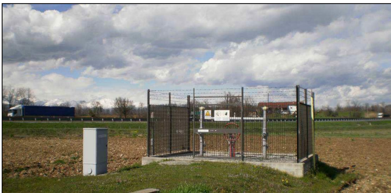
Figura 3-L: Esempio di impianto al termine dei lavori
