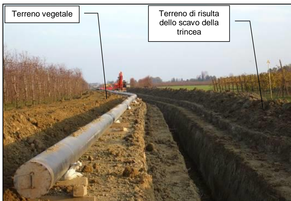
Figura 3-E: Scavo della trincea
