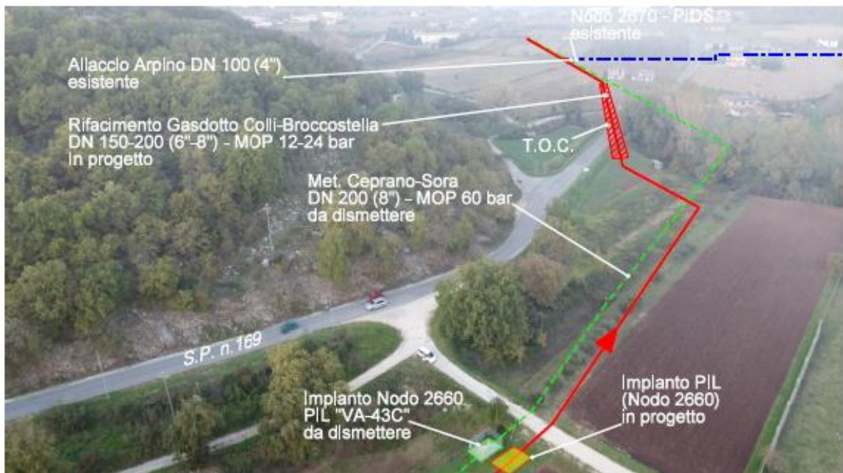
Fig. 10 - Panoramica del nuovo tratto con attraversamento in TOC della SP n.169 e torrente Forma Taverna. (in rosso il tracciato in progetto, in verde la dismissione).
