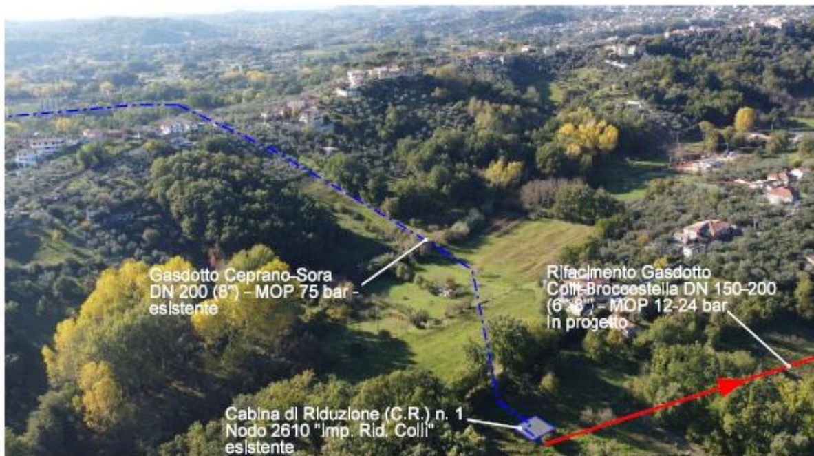
Fig. 3 - Panoramica del punto di partenza del Gasdotto Colli-Broccostella DN 150-200 (6"-8") – MOP 12-24 bar oggetto di rifacimento. (in rosso il tracciato in progetto, in blu in esercizio).
