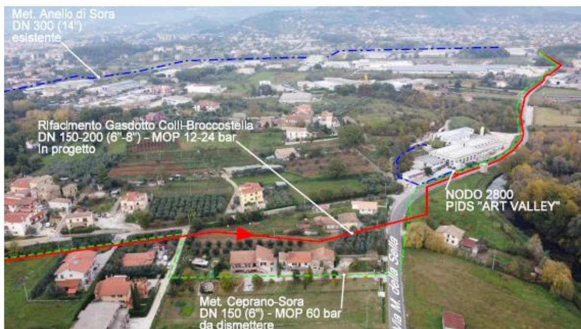
Fig. 18 - Panoramica del nuovo tratto con l'attraversamento in spingitubo di via Madonna della Sella e percorrenza stradale. (in rosso il tracciato in progetto, in verde la dismissione, in blu met. esistente).
