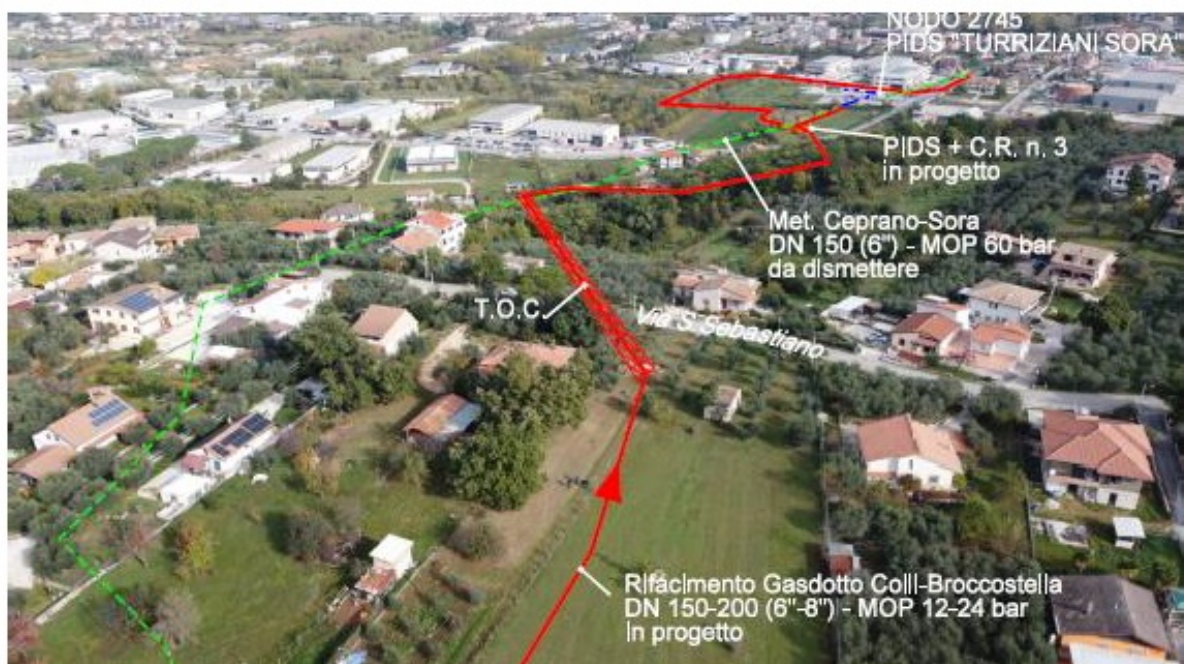
Fig. 14 - Panoramica del nuovo tratto con l'attraversamento in TOC di area boscata e sullo sfondo andamento condotte in prossimità del distributore "Turriziani". (in rosso il tracciato in progetto, in verde la dismissione).
