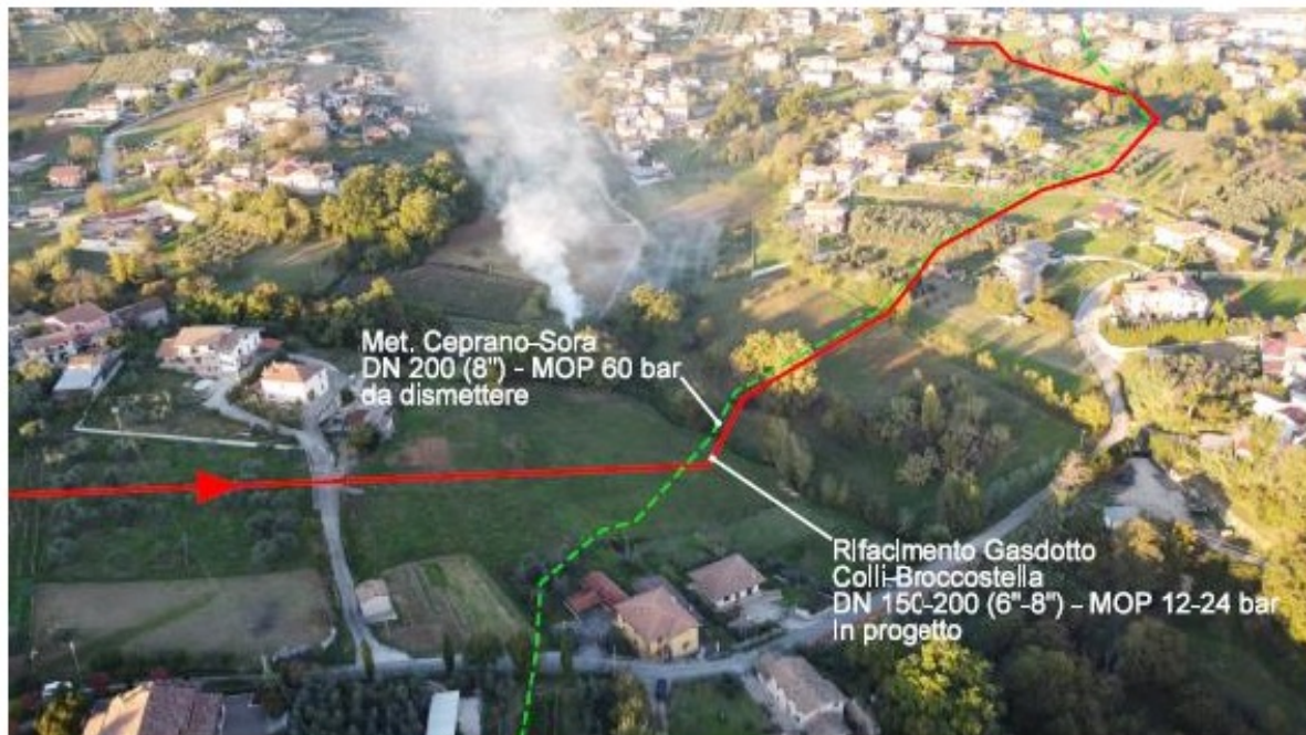
Fig. 8 - Panoramica del nuovo tratto con parallelismo alla condotta da dismettere. (in rosso il tracciato in progetto, in verde la dismissione).
