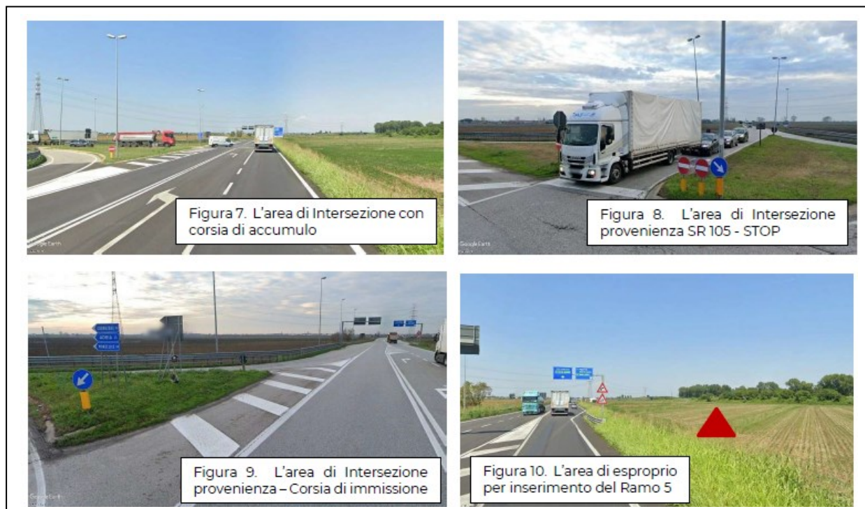
Fig. 3 – Riprese fotografiche dello stato attuale dello svincolo (Fonte: Allegato alla Lista di controllo Relazione generale e tecnica)
