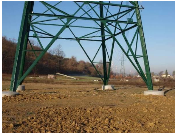
Foto 10 – Esempio di ripristino di un'area di micro-cantiere
