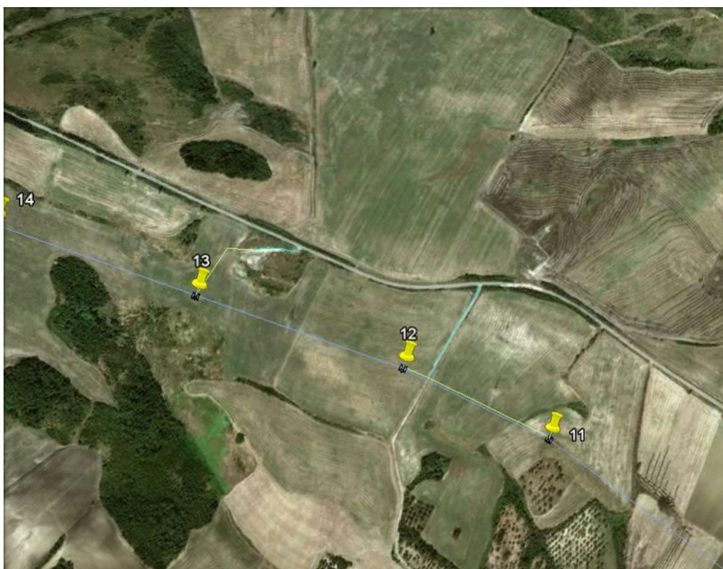
Foto 7 - Particolare su foto aerea della pista di collegamento dei sostegni 12 e 13 alla viabilità carrabile
