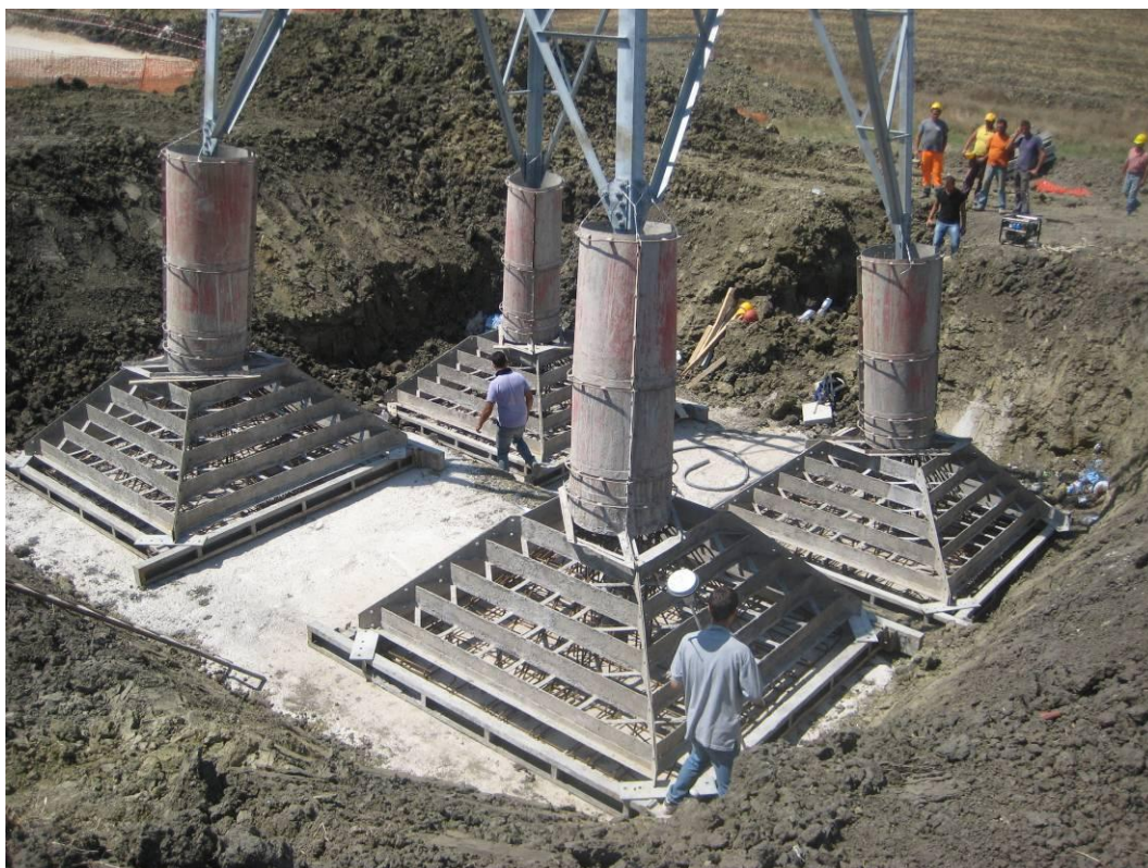
Foto 3 - Area di micro-cantiere tipo per l'istallazione di un sostegno 150 kV
