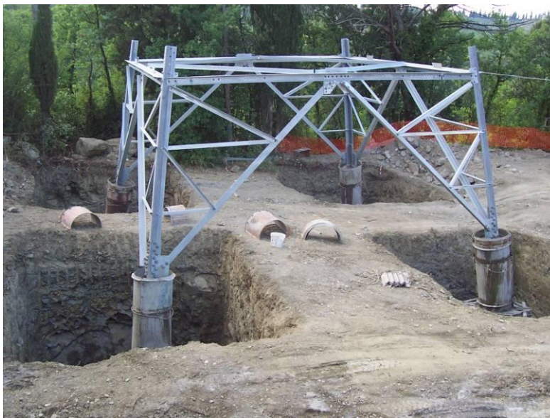
Foto 9 - Esempio di fondazione di un sostegno
