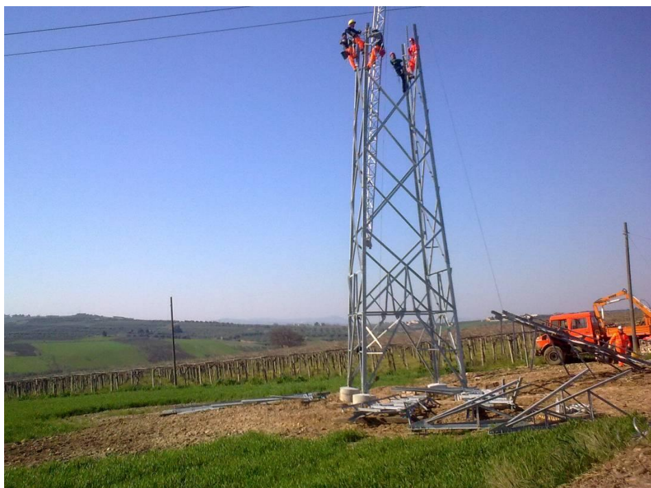
Foto 2 - Installazione di un sostegno in una linea 150 kV
