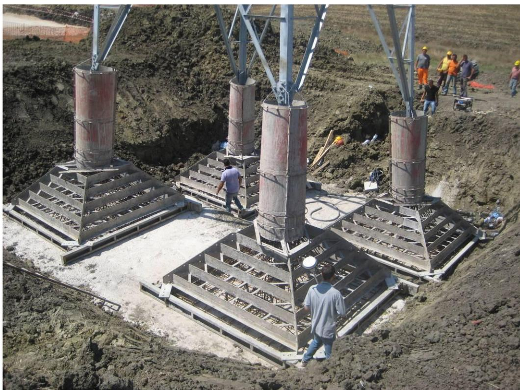
Foto 3 - Area di micro-cantiere tipo per l'installazione di un sostegno 150 kV
