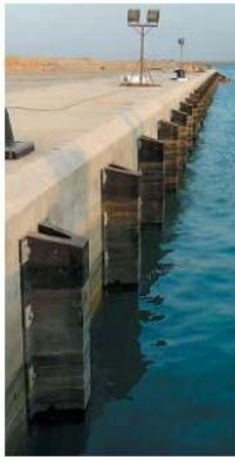
Figura 20 –Esempio di applicazione del parabordo di tipo “ AN ARC FENDER”.
