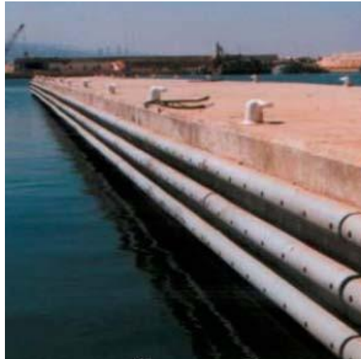
Figura 22 –Esempio di applicazione del parabordo di tipo “ DD FENDER”.
