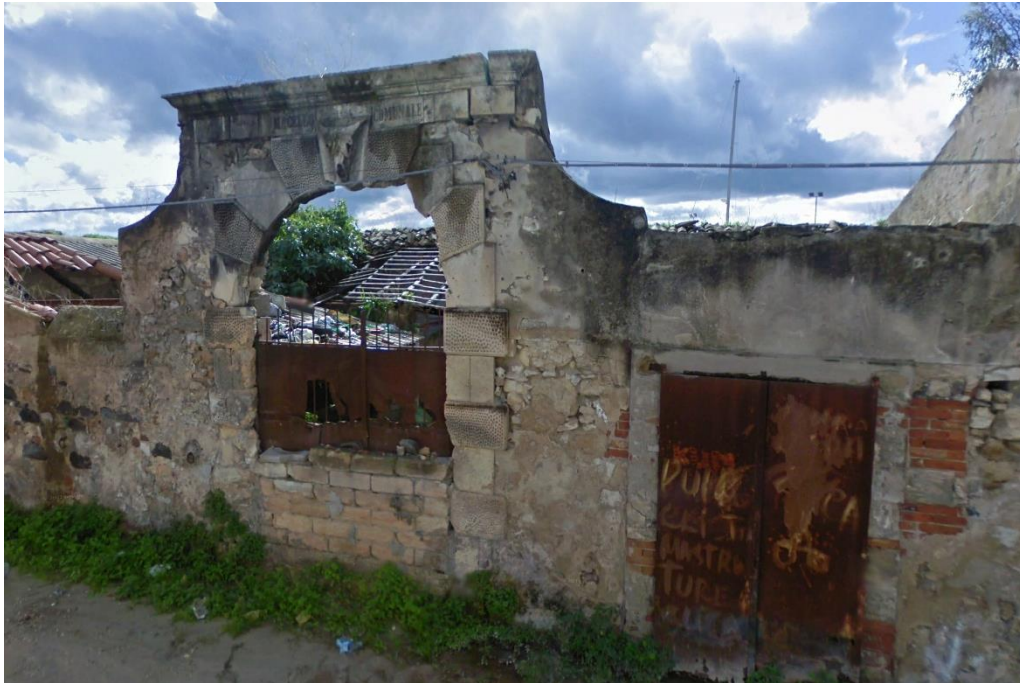
Figura 7-12 Portale del Macello Comunale di Siracusa
