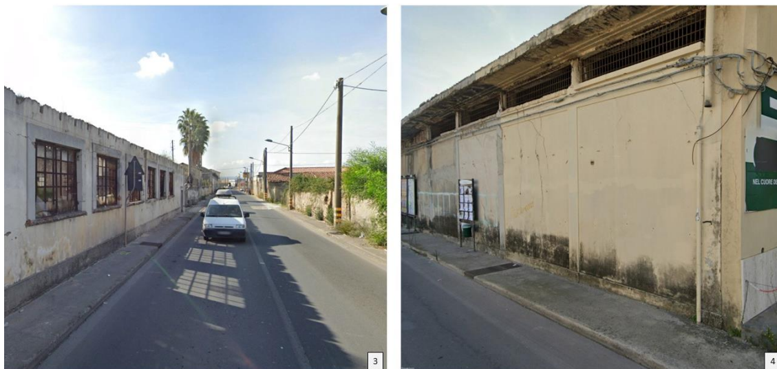
Figura 7-5 Localizzazione dei punti visuali 3 e 4 che rappresentano il perimetro dell'area industriale SPERO, su via Elorina
