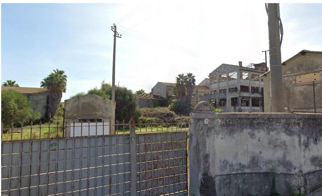
Figura 7-11 Vista dell’area Ex S.P.E.R.O. con le sue strutture in abbandono, nell’area industriale di Siracusa, ripresa effettuata da via Elorina
