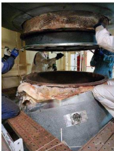
Figura 2.3 – foto dell’installazione del catalizzatore prototipo al camino E4
