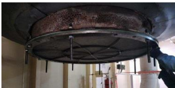
Figura 2.3 – foto dell’installazione del catalizzatore prototipo al camino E4
