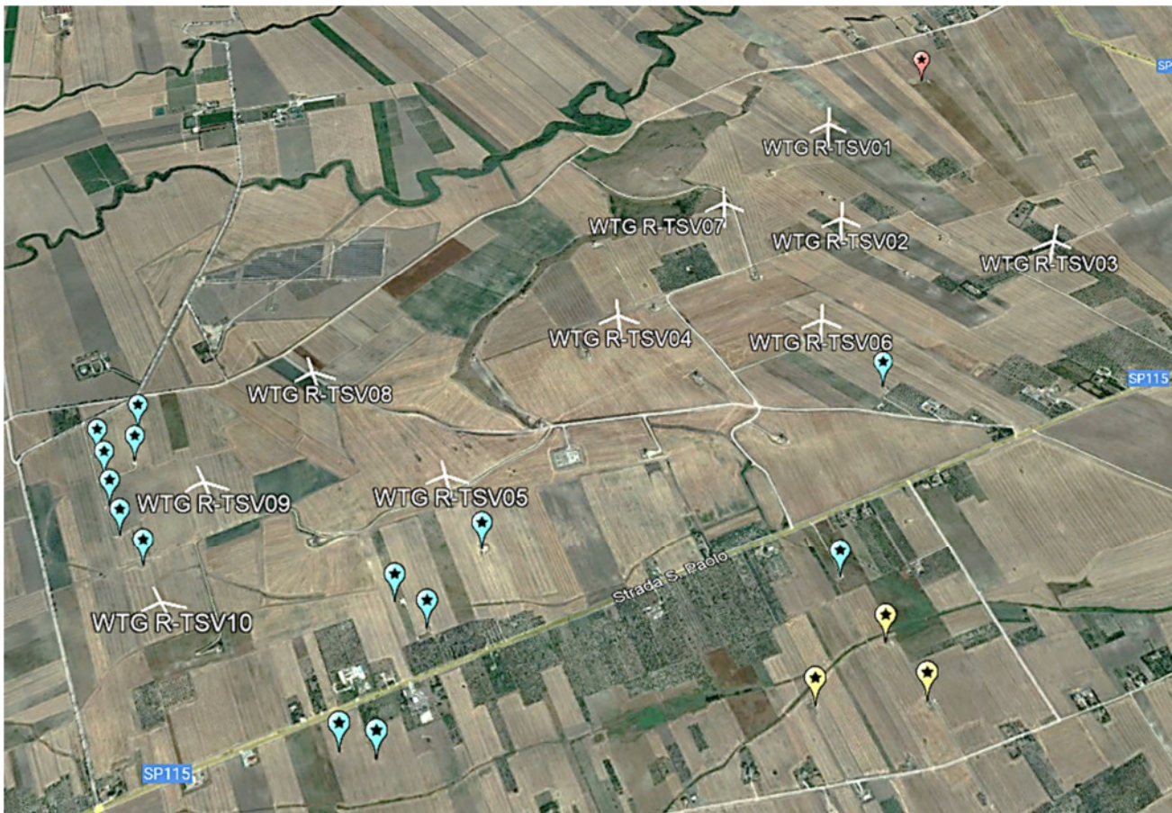
Figura 10: Vista delle turbine terze attorno al parco eolico di progetto
