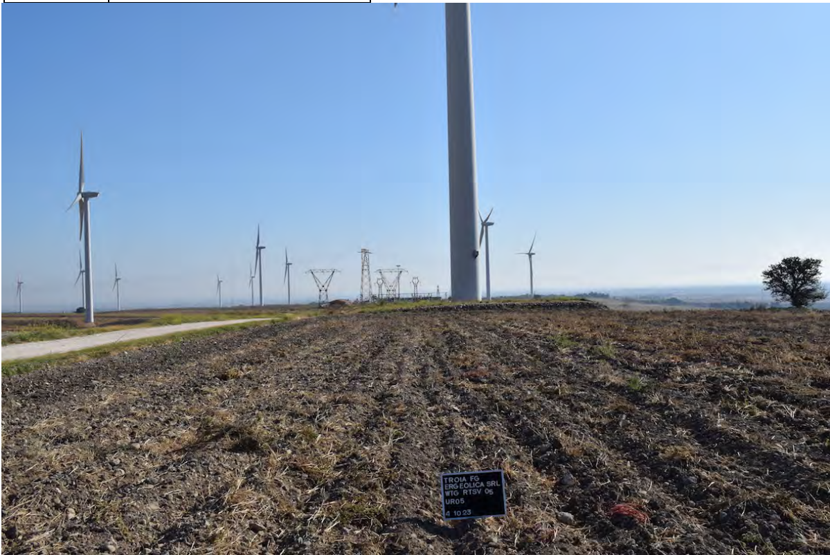
Foto 21 Area plinto e piazzola TSV05
