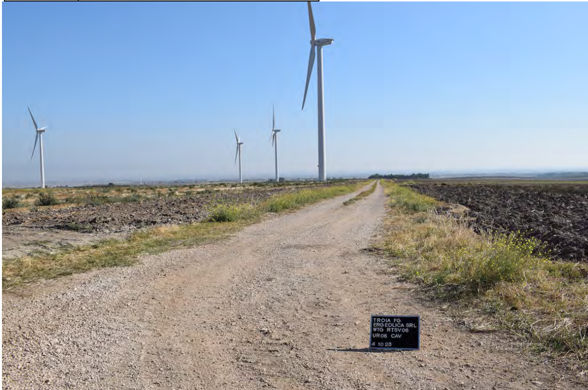
Foto 24 Cavidotto e pista di accesso TSV06
