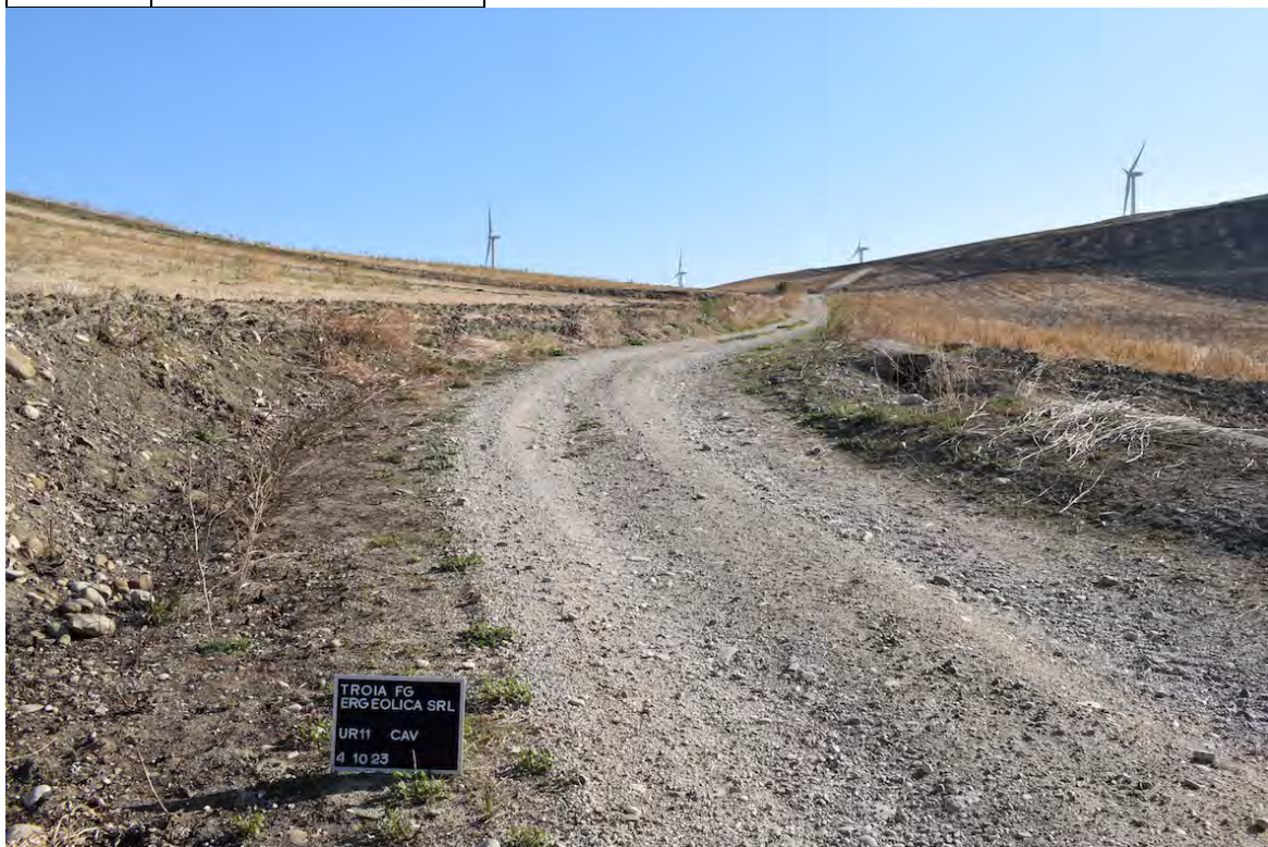
Foto 34 Cavidotto "Tratto W"
