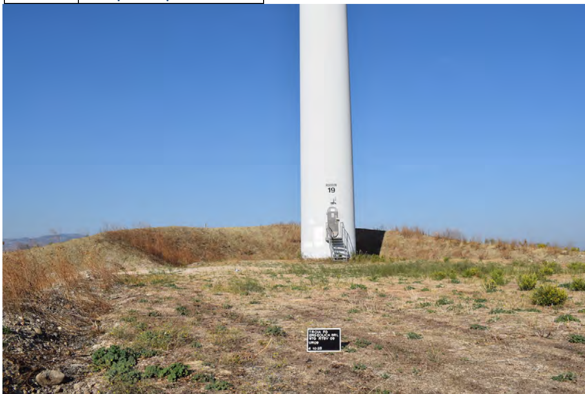
Foto 30 | Area plinto e piazzola TSV09
