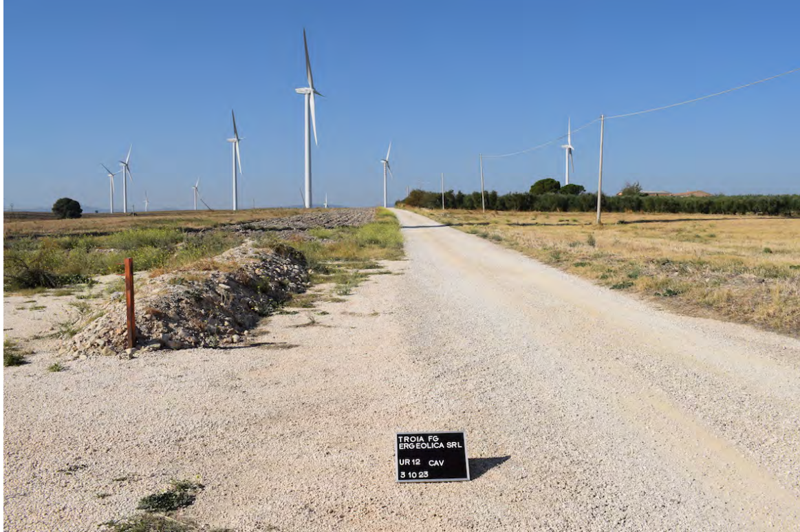
Foto 36 Cavidotto "Tratto E"
