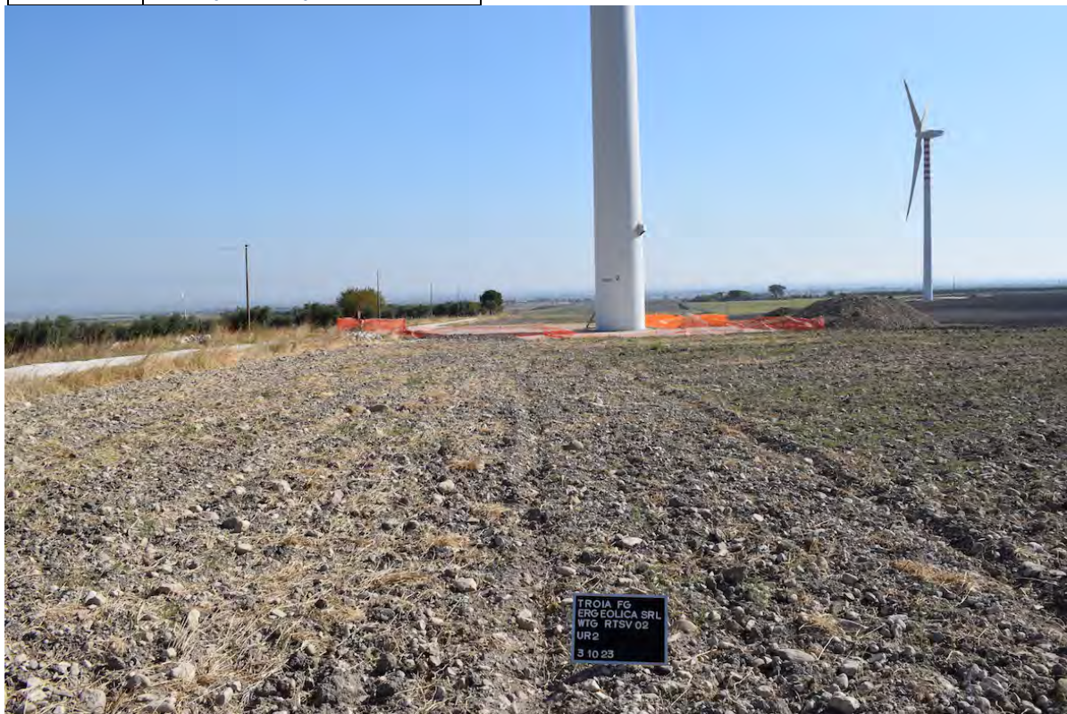
Foto 16 Area plinto e piazzola TSV02
