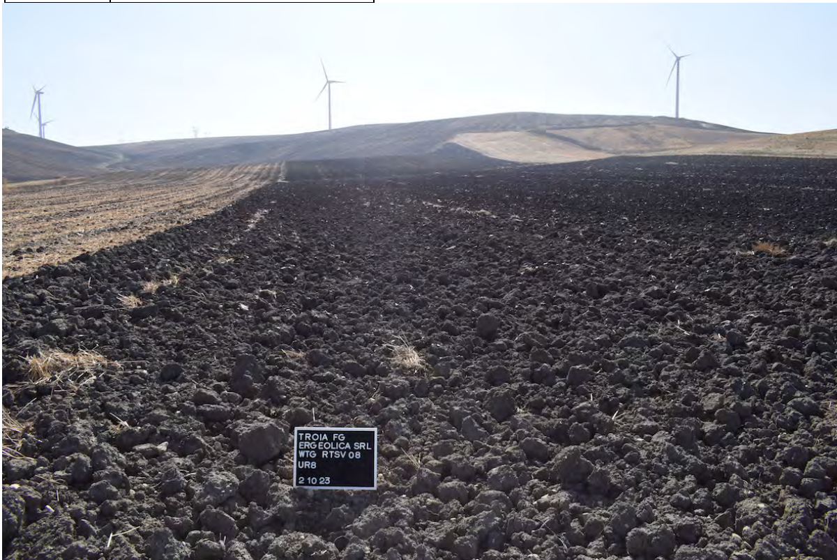
Foto 28 Area plinto e piazzola TSV08
