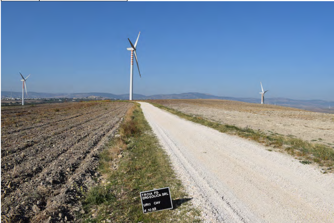
Foto 35 Cavidotto "Tratto W"
