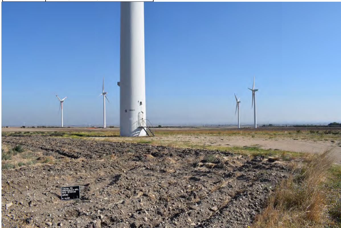
Foto 23 Area plinto e piazzola TSV06
