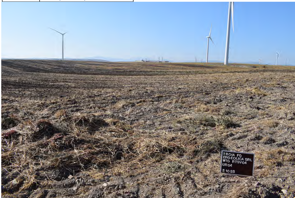
Foto 19 Area plinto e piazzola TSV04
