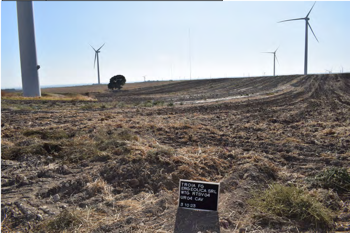
Foto 20 Cavidotto e pista di accesso TSV04
