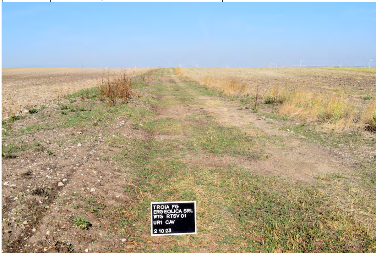
Foto 15 Cavidotto e pista di accesso TSV01
