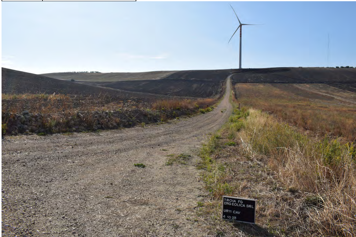
Foto 33 Cavidotto "Tratto W"
