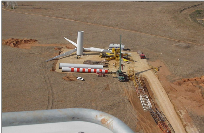
Foto 1. Piazzola per il montaggio dell'aerogeneratore
