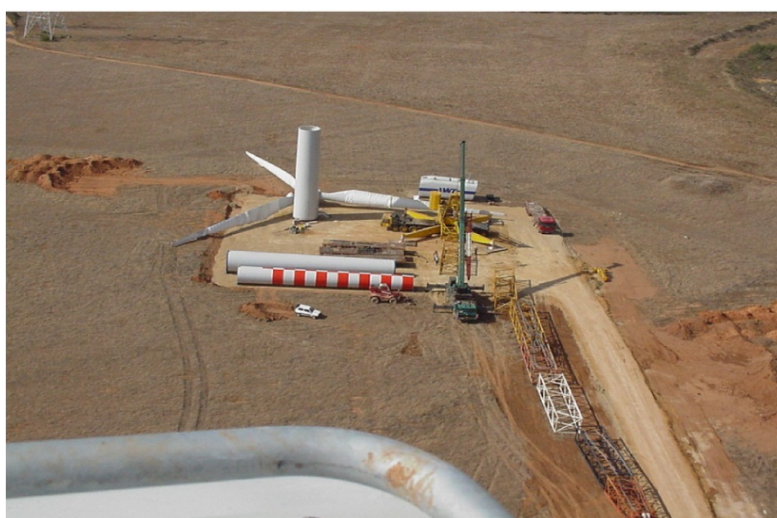
Figura 3 – Piazzola per il montaggio dell'aerogeneratore
