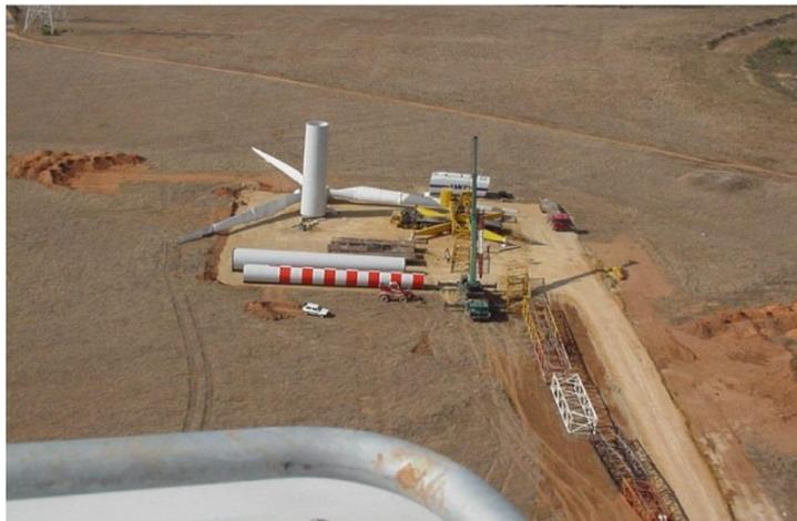
Figura 7 – Piazzola per il montaggio dell'aerogeneratore
